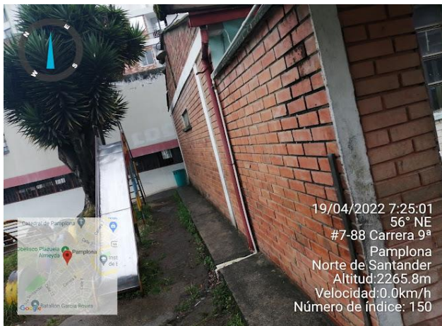
Fachada del bloque de transición
