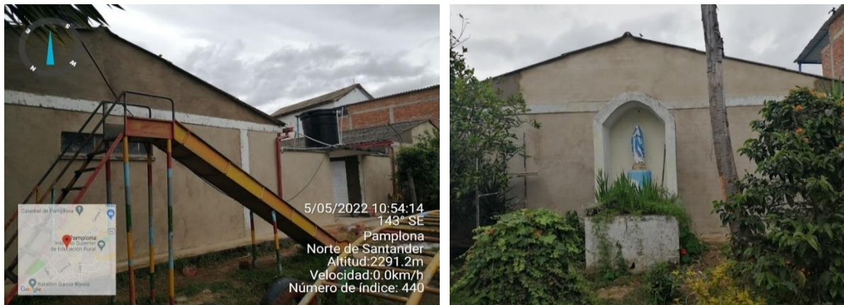
Pañete muro a la vista
