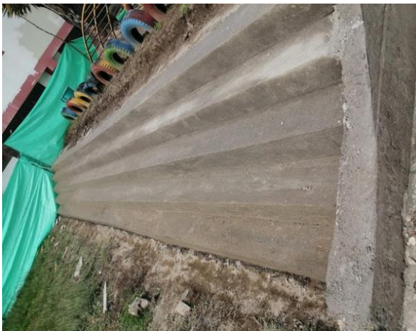
Recalce y pintura de gradería existente
