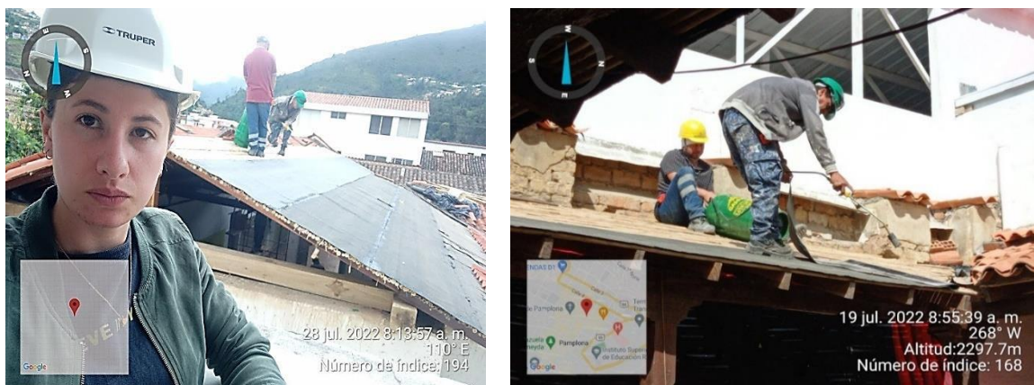
Instalación manto asfáltico
