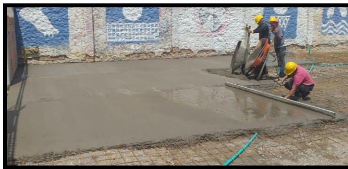
Ilustración 11: Disposición del concreto de 21\text{Mpa} para la Losa de Antepiso..
