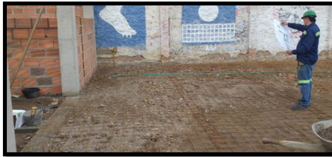
Ilustración 10: Extensión de malla electrosoldada de 5\text{mm} , previo a la Losa de concreto de 21 \text{ Mpa} Estancias.
