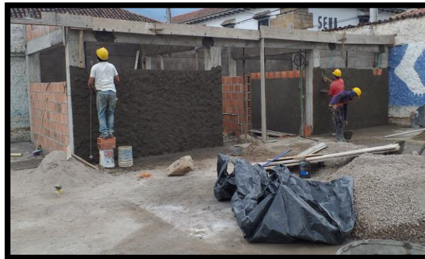
Ilustración 24: Disposición de pañete exterior e interior en obra.
