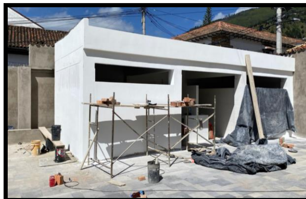
Ilustración 25: Disposición de pañete exterior e interior en obra.
