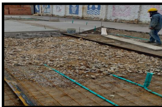
Ilustración 23: Vaciado de la placa de contrapiso.
