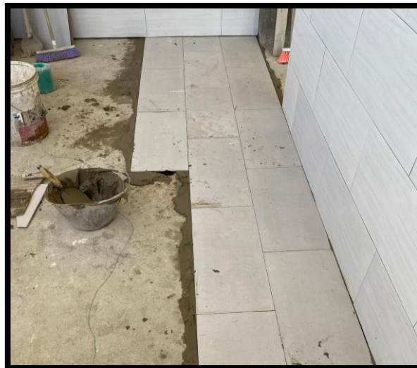
Ilustración 15: Instalación de enchape para piso baño.
