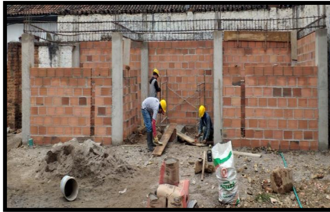
Ilustración 13: bloques ejecutados en batería sanitaria.
