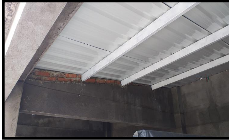
Ilustración 19: Instalación cubierta master 1000.
