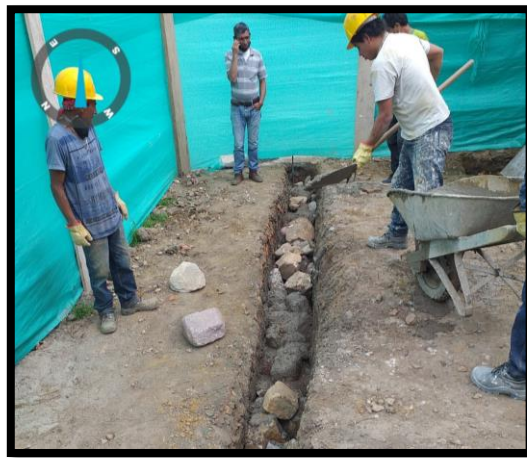
Ilustración 9: Primer control de equipos de seguridad en obra.
