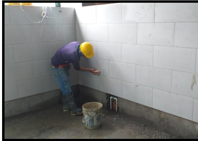
Ilustración 14: Instalación de enchape para paredes.
