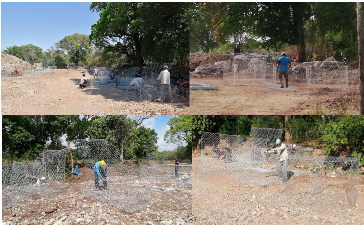
Ilustración 29 Armado de la malla
