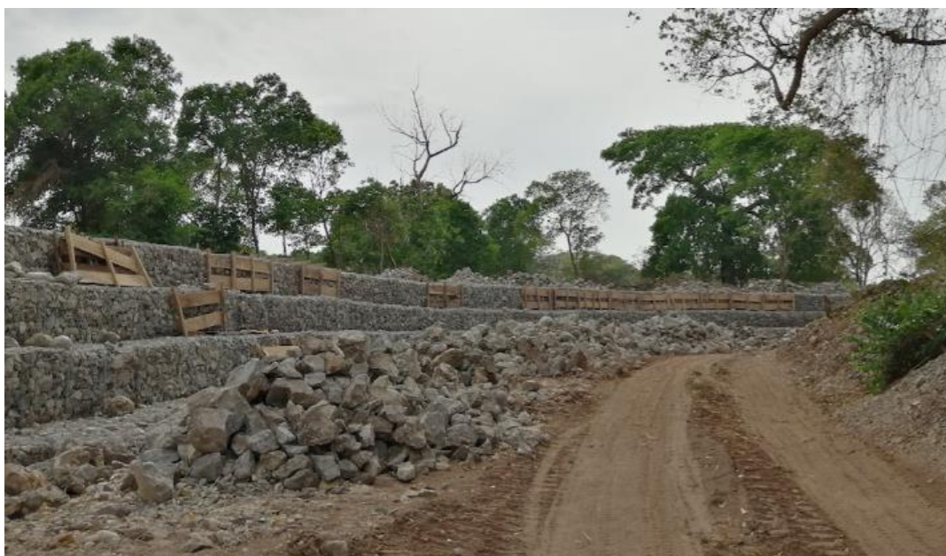
Ilustración 20 Ausencia de malla
