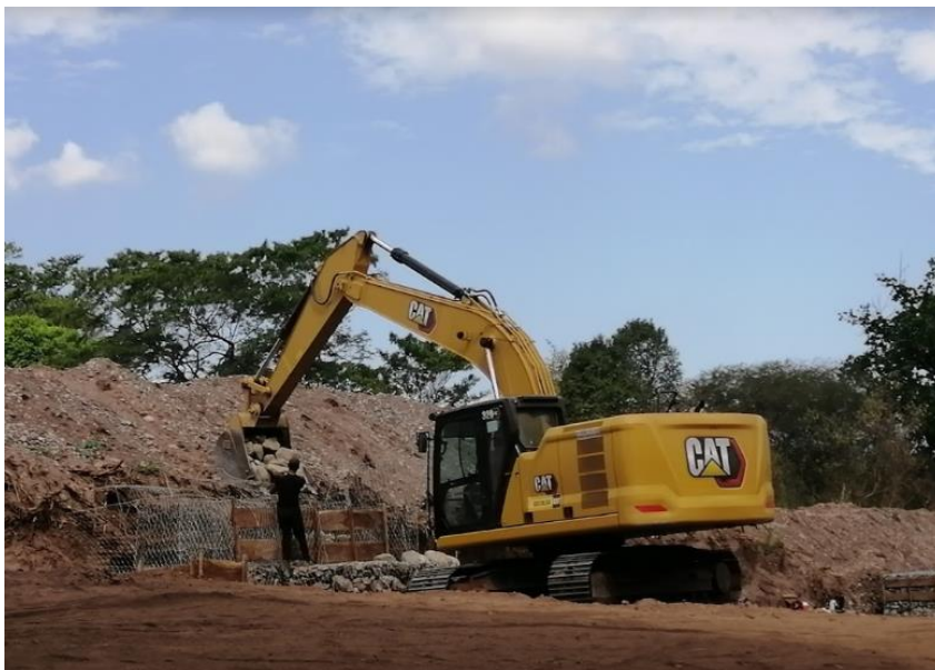
Ilustración 35 Excavadora en apoyo al relleno de mallas
