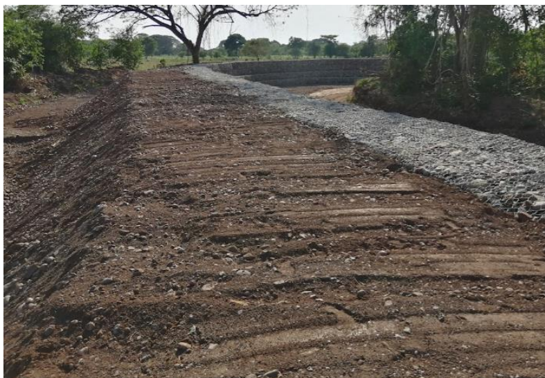
Ilustración 37 Jarrillón conformado
