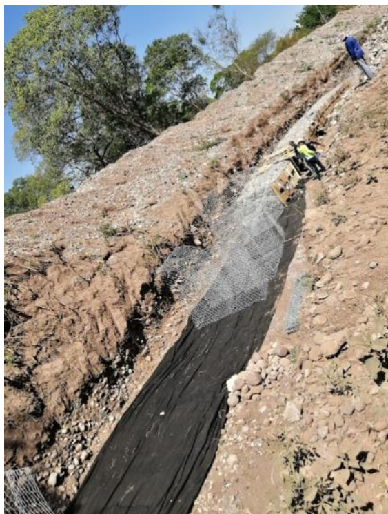
Ilustración 31 Ubicación del geotextil
