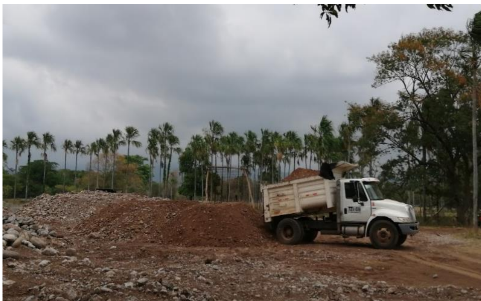
Ilustración 24 Material para la conformación del jarrillón
