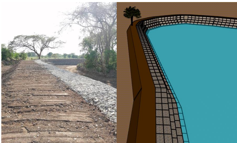
Ilustración 39 Muro en gaviones
