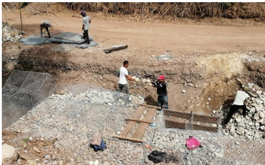
Ilustración 34 Relleno de los gaviones
