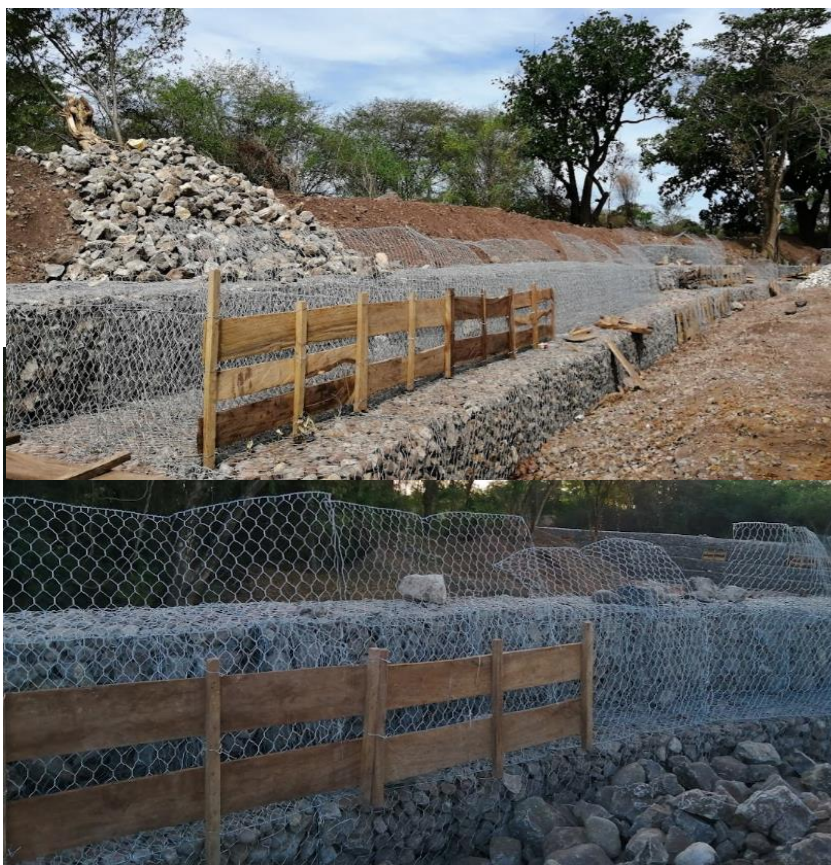
Ilustración 32 Formaleteado las mallas
