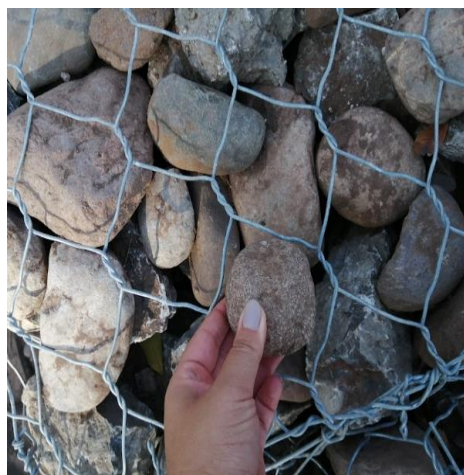
Ilustración 14 Diámetro inferior al diámetro de la malla
