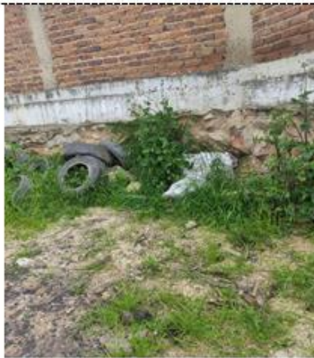
Vista con muro Fecha: 01/12/2021
