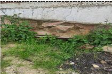
Vista muro Fecha: 01/12/2021
