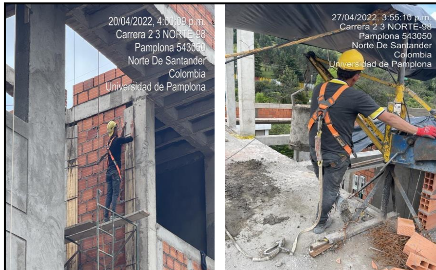
Ilustración 18: Uso del arnés para trabajos en alturas.
