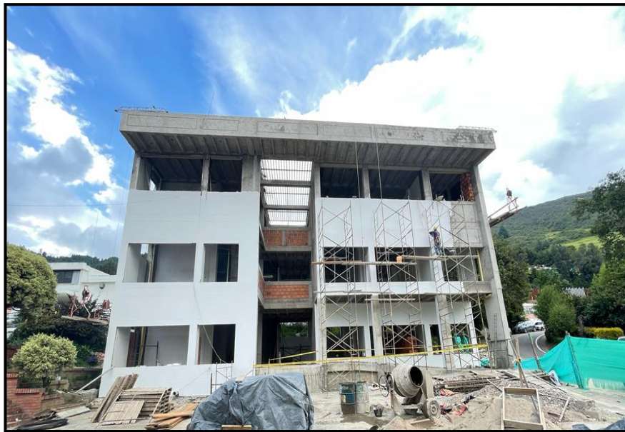
Ilustración 26: Estado de la obra al culminar la práctica.
