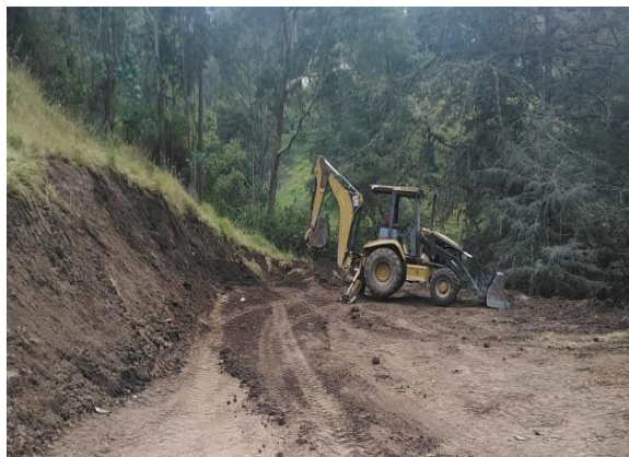
ilustración 21. Excavación material sin clasificar
