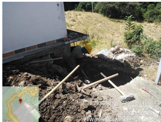
ilustración 23. Demoliciones y excavaciones.
