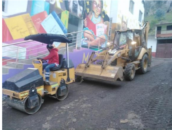
ilustración 62. Sub base granular compactada
