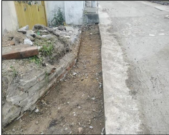
ilustración 67. Excavación manual sin clasificar andén
