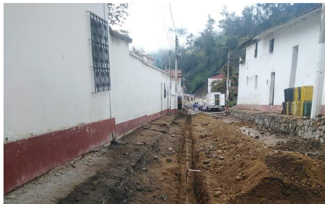
ilustración 34. Excavación manual para instalación de tubería
