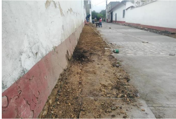
ilustración 50. Excavación manual sin clasificar andén
