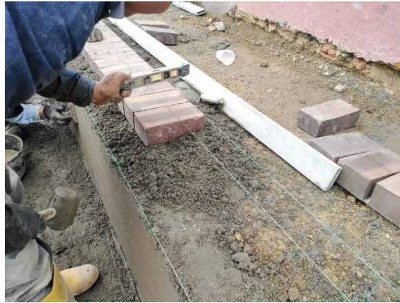
ilustración 51. Suministro e instalación de adoquín
