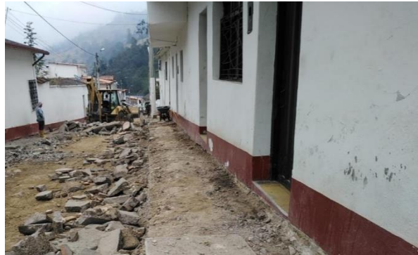
ilustración 33. Demolición andenes existentes
