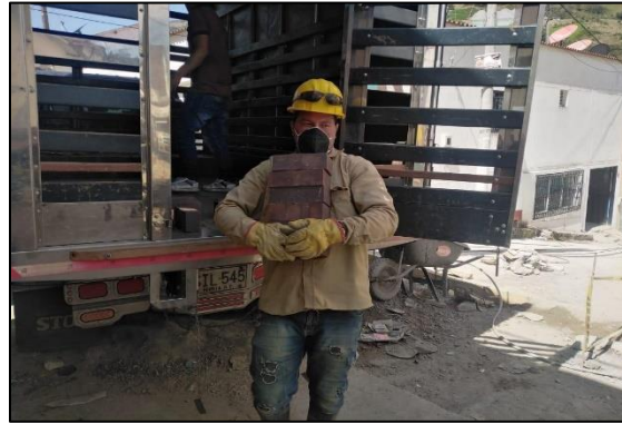
ilustración 68. Suministro e instalación de adoquín
