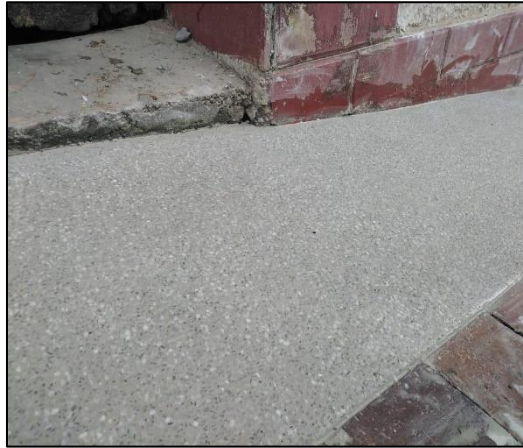
Ilustración 71. Suministro e instalación piso de granito lavado
