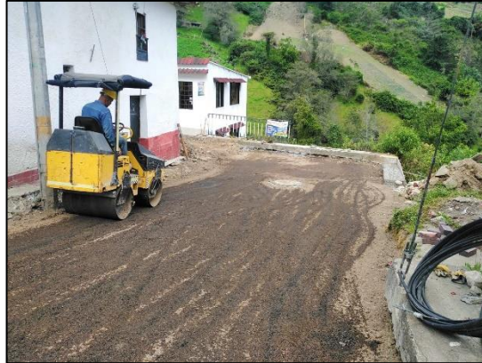
Ilustración 4 compactación sub-base.
