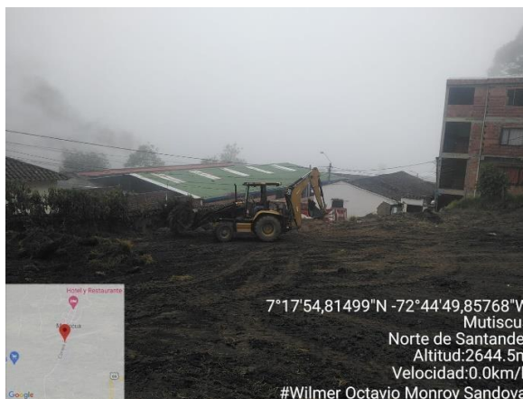
ilustración 22. Retiro de material de excavación
