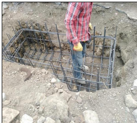
ilustración 72. Cajón en concreto para sumidero
