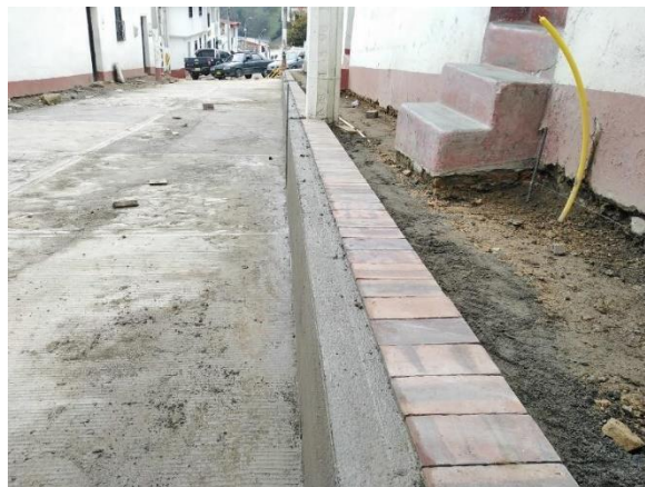
ilustración 52. Sardinell en concreto
