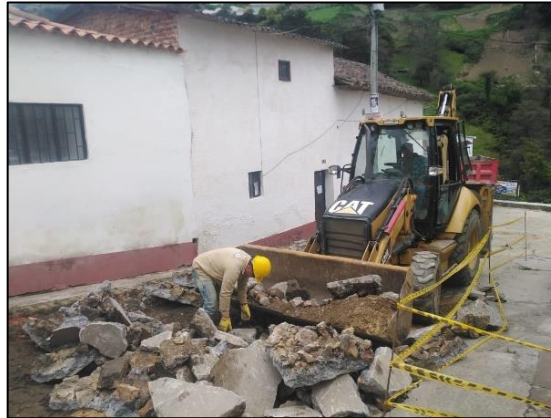
ilustración 11. Retiro de demolición.
