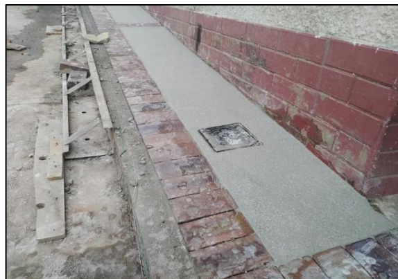
ilustración 69. Sardinel en concreto
