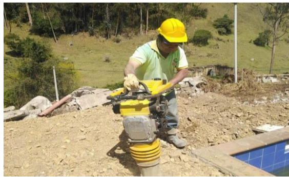
ilustración 40. Compactación de relleno
