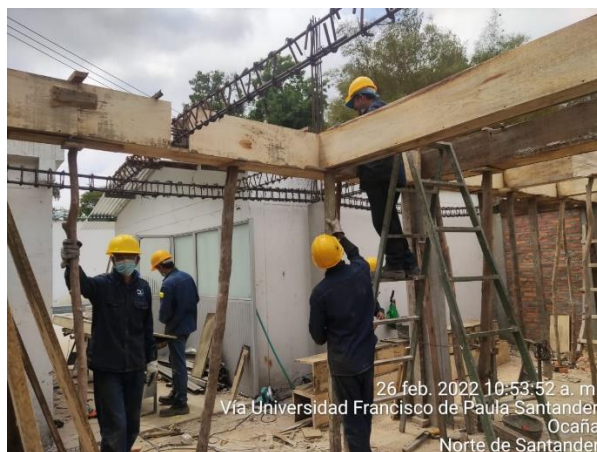
Ilustración 27. Uso de casco en obra Fuente: Elaboración Propia.
