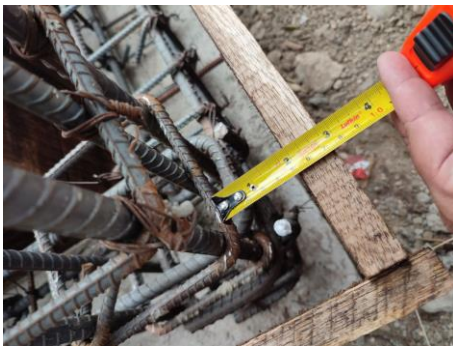
Ilustración 13. Distancia de recubrimiento en viga de cimentación. Fuente: Elaboración Propia.
