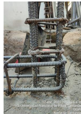
Ilustración 14. Barra N°5 W60 en viga de cimentación. Fuente: Elaboración Propia.
