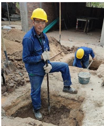
Ilustración 28. Uso de gafas de protección en obra Elaboración: Fuente Propia.
