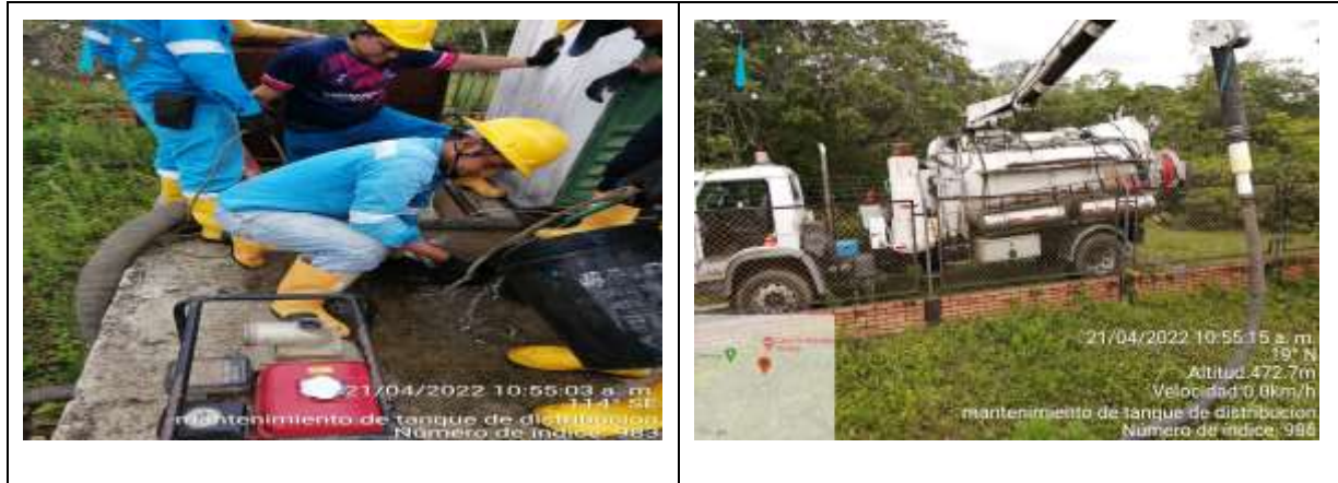
Ilustración 26. Mantenimiento al Tanque de Distribución de Agua Potable
