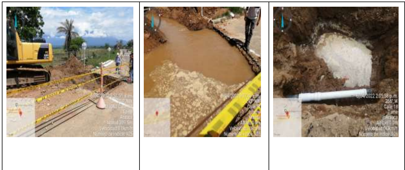
Ilustración 24. Apoyo a Reparaciones y Obras de Canales Abiertos
