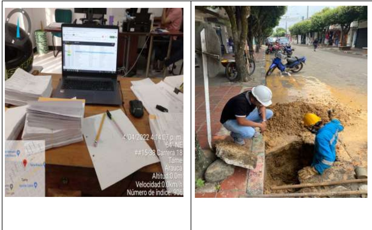
Ilustración 6. Control de Materiales En Campo
