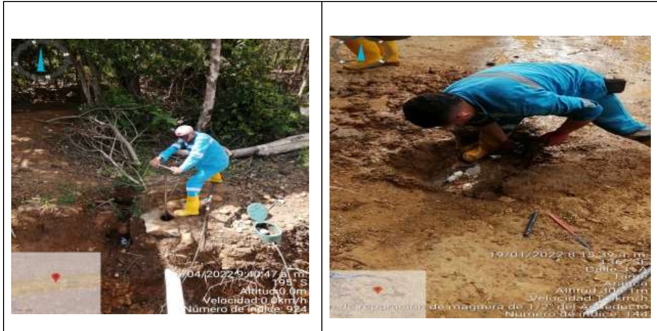
Ilustración 13. Verificación en campo de EPPS
