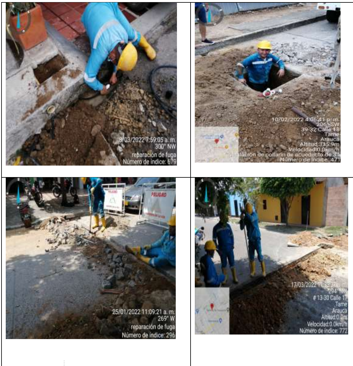
Ilustración 21. Identificación de falta de coordinación de material
