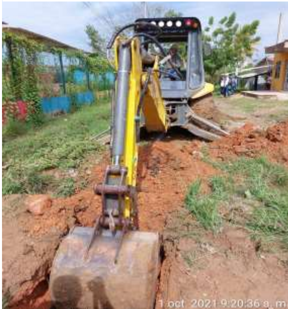
Fotografía 7 Exc. Mecánica Tub. 8"
