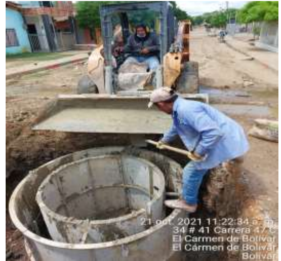
Fotografía 14 Fundida de Mh
