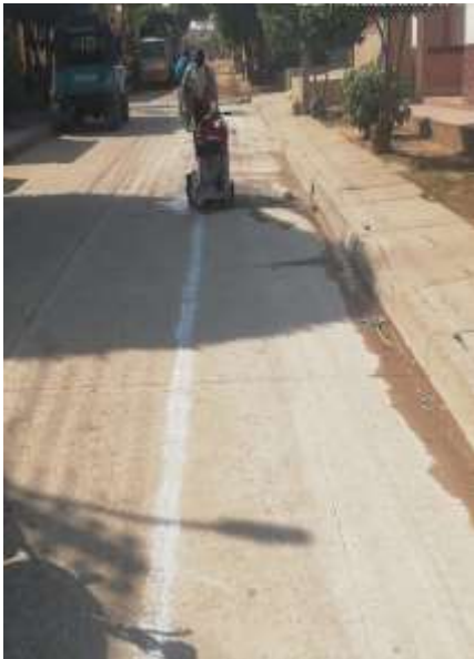
Fotografía 30 Corte Pavimento
