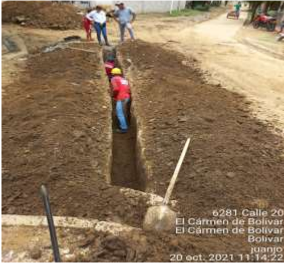
Fotografía 4 Exc. Manual Tub. 10"
