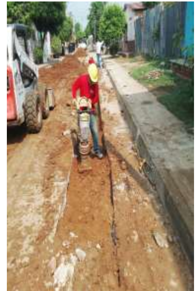
Fotografía 28 Compactación de Terreno
