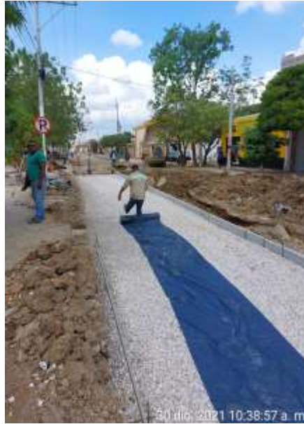
Fotografía 41 Colocación de Plástico
