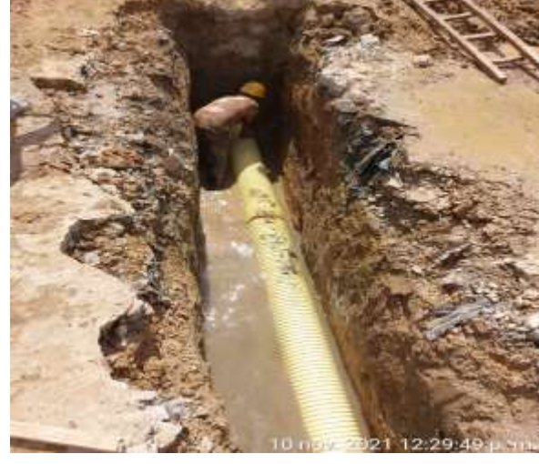
Fotografía 20 Instalación de Tubería de 10"
