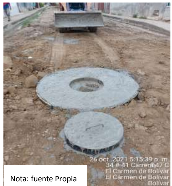
Fotografía 16 Fundida de Tapa de Mh
