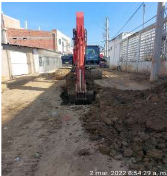
Fotografía 10 Exc. Mecánica Tub. 30"
