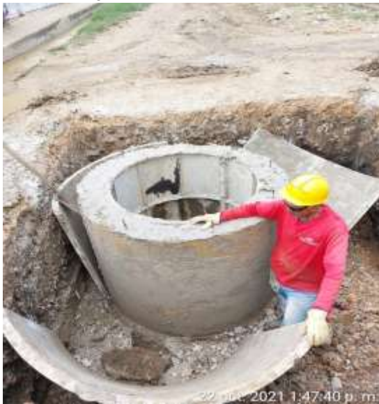
Fotografía 17 Desencofrado de Mh
