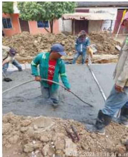
Fotografía 39 Vibrado de Concreto
