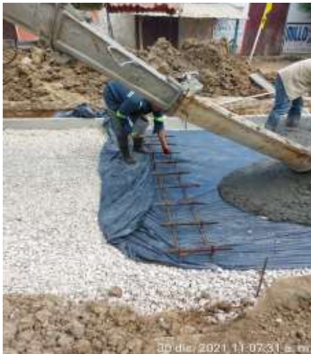
Fotografía 40 Colocación de Juntas
