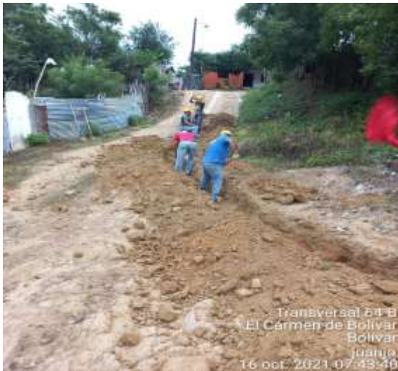
Fotografía 6 Exc. Manual Tub. 8"
