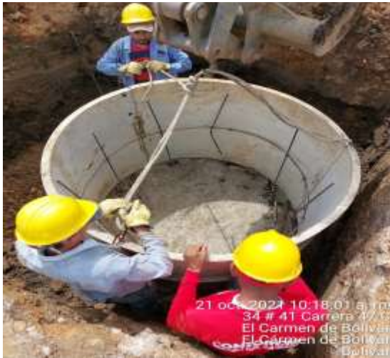
Fotografía 15 Encofrado de Mh
