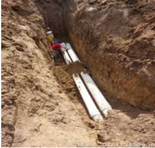
Fotografía 21 Instalación de Tubería Sifón Ica
