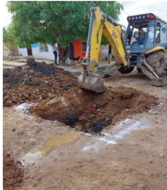
Fotografía 8 Exc. Mecánica Construcción Mh
