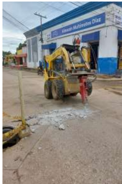
Fotografía 29 Demolición Pavimento
