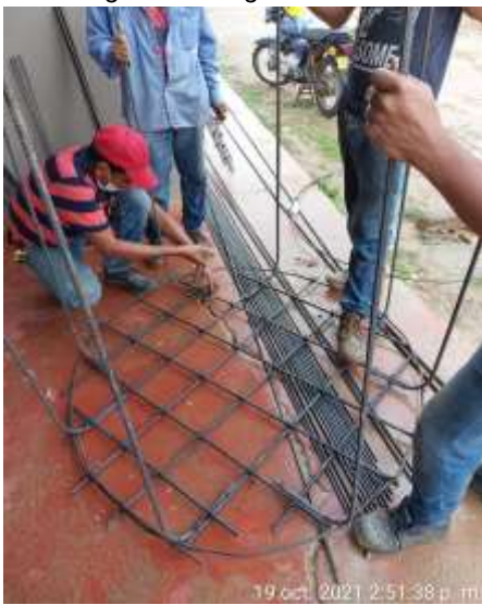
Fotografía 13 Figurado de Acero
