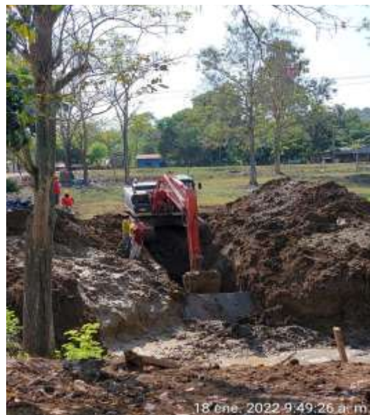
Fotografía 9 Exc. Mecánica Sifón Ica
