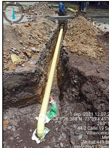
Figura 9, Excavación para instalación de tubería de domiciliaria.
