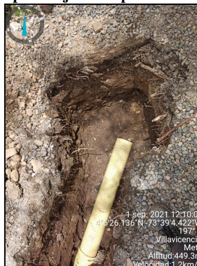
Figura 10, Excavación para caja de inspección.
