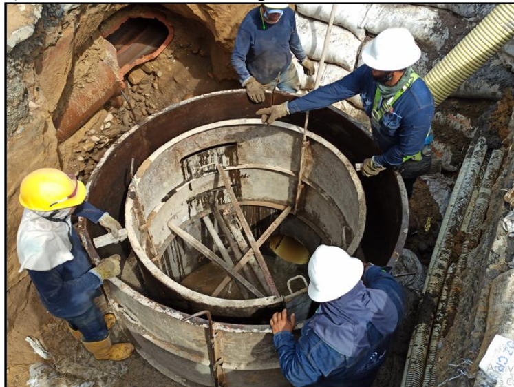
Figura 32, Ubicación de formaletas para anillo de D= 1.20 m.
