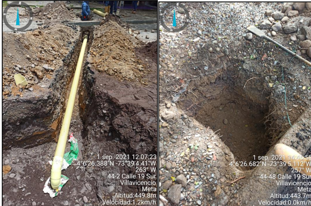
Figura 19, excavación e instalación de tubería, para domiciliaria.
