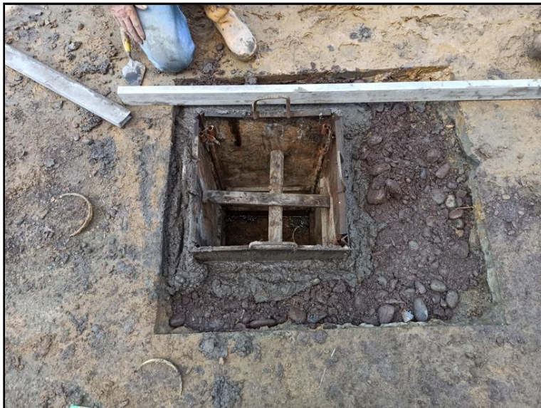
Figura 35, Montaje de Formaletas para caja de inspección.
