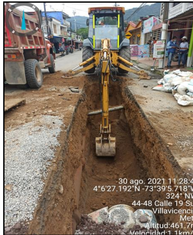
Figura 14, Instalación de tubería sin entibado por tubo de agua potable.
