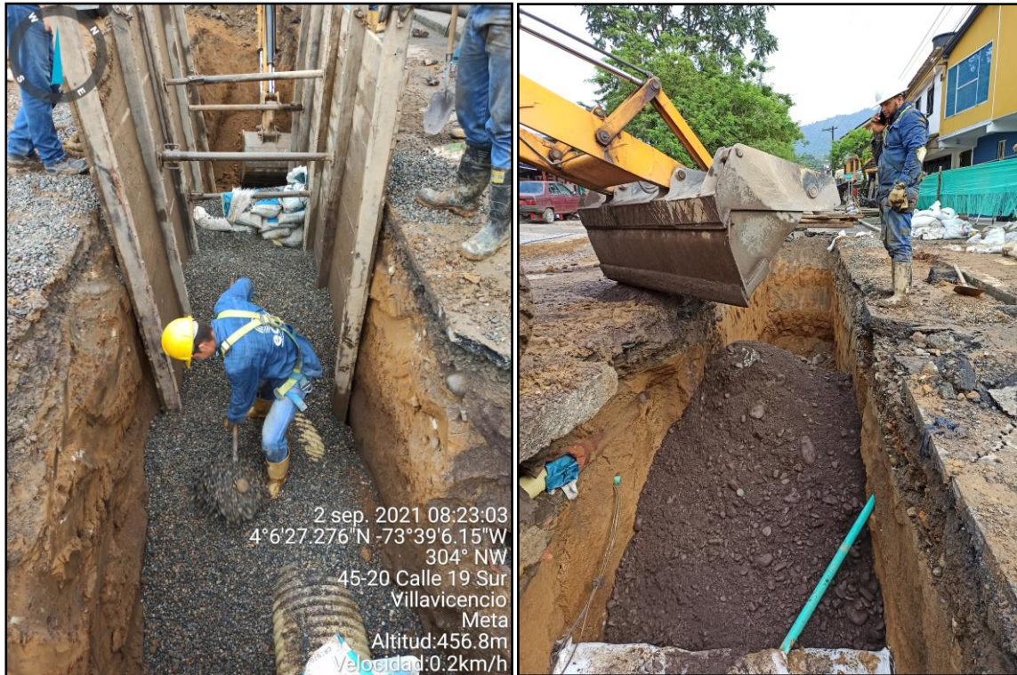
Figura 18, Instalación de material de base y de relleno.
