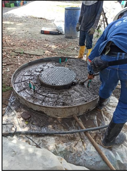
Figura 36, Montaje de Formaletas para la tapa de pozo de inspección.
