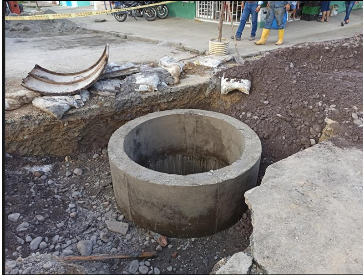
Figura 33, Retiro de las formaletas del anillo de pozo.
