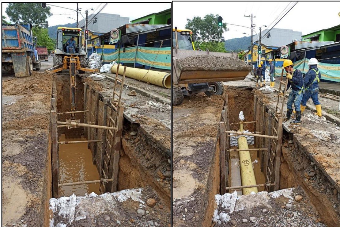
Figura 17, Excavación e instalación de tubería, para red de alcantarillado sanitario.
