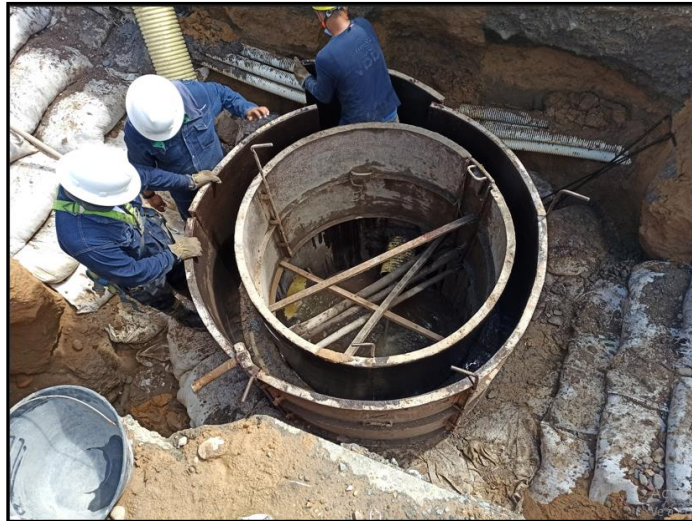
Figura 35, Montaje de Formaletas para caja de inspección.
