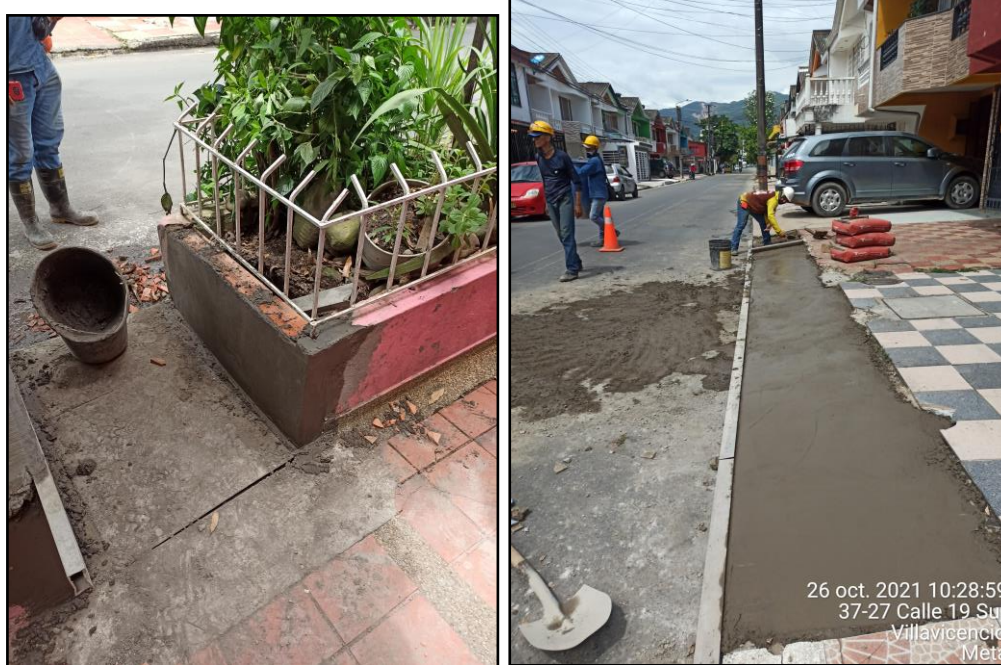
Figura 21, Recuperación de andenes afectados.
