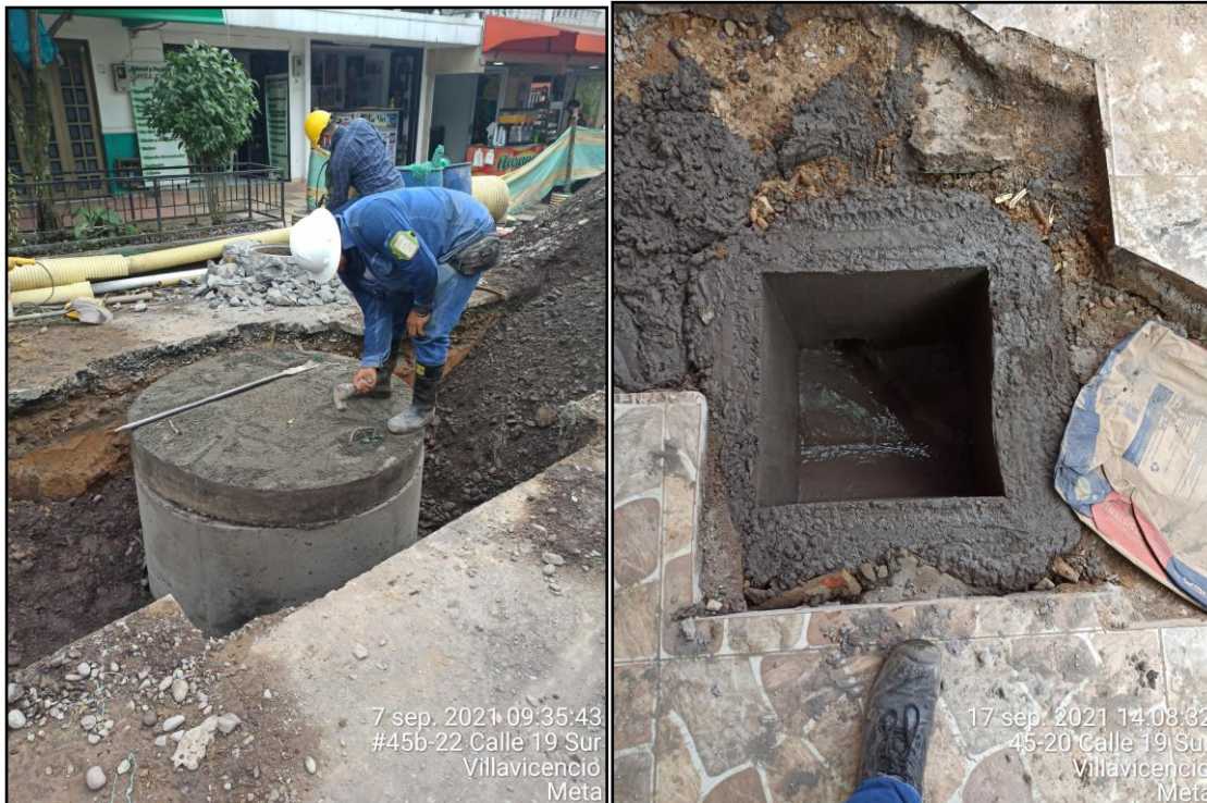
Figura 20, Elementos estructurales, pozo y caja de inspección.
