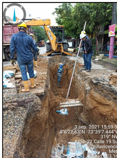
Figura 13, Instalación de tubería de 20” sin entibado por tubería de telecomunicaciones.
