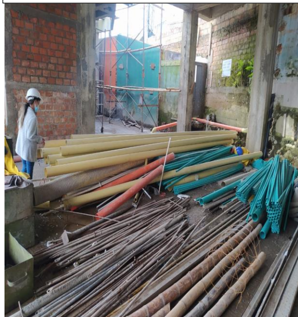
Verificación de la calidad de tubería sanitaria, hidráulica y eléctrica.
