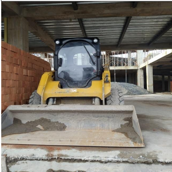
Verificación de maquinaria en obra (Minicargador Caterpillar)
