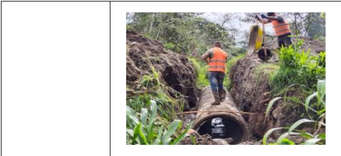
Cuadro 20 Registro fotográfico de los procesos constructivos y su respectiva supervisión, Fuente: Propia
