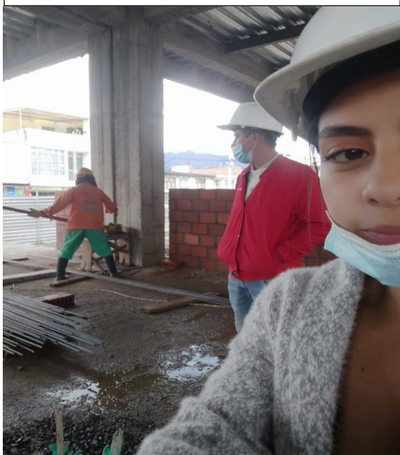
Supervisión en la actividad de figurado de acero
