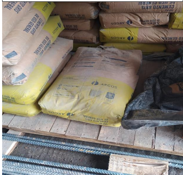
Verificación del adecuado almacenamiento del cemento (Argos) y calidad.
