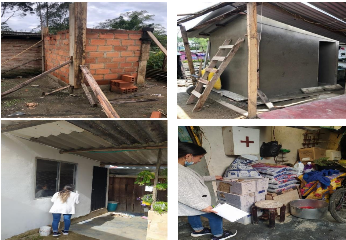
Ilustración 14 Supervisión al contrato de obra de Diagnóstico y Construcción para el mejoramiento de Vivienda, Fuente: Propia
