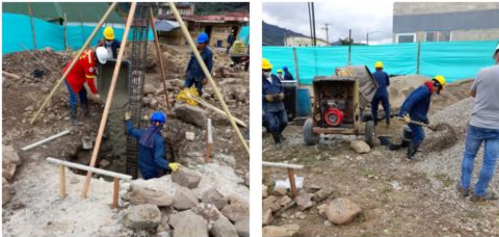
Ilustración 62. Preparación de concreto in situ.
