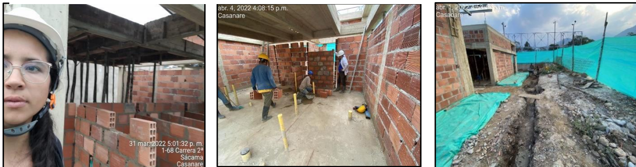
Ilustración 39. Registro fotográfico séptimo corte de actividades ejecutadas.
