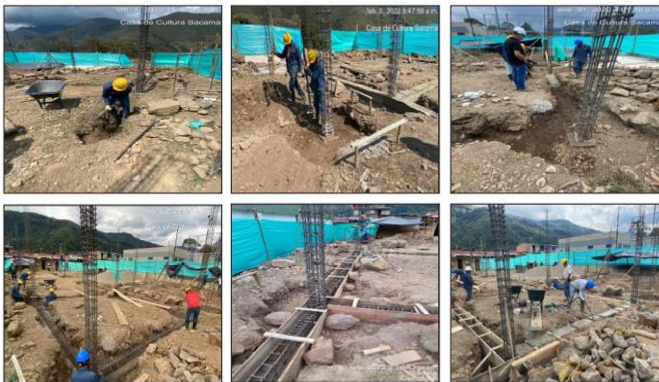
Ilustración 35. Registro fotográfico tercer corte actividades ejecutadas.
