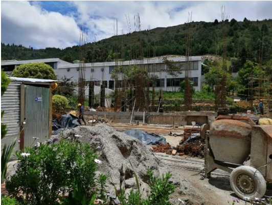
Figura 17. Almacenamiento de agregado
