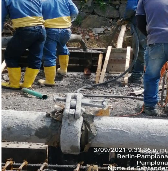
Figura 21. Aplicación de concreto premezclado en vigas de cimentación.
