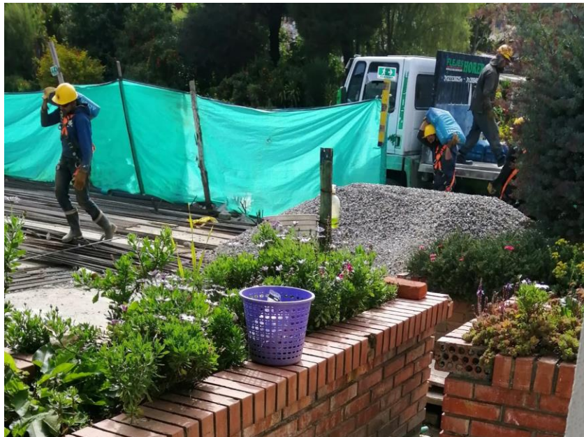
Figura 17. Almacenamiento de agregado
