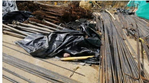
Figura 12. Almacenamiento de acero
