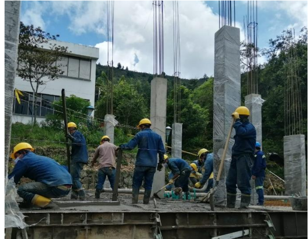
Figura 22. Aplicación de concreto premezclado en placa de ante piso.
