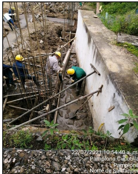
Figura 10. Fundida de muro de contención con concreto ciclópeo
