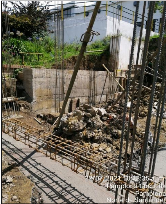
Figura 10. Fundida de muro de contención con concreto ciclópeo
