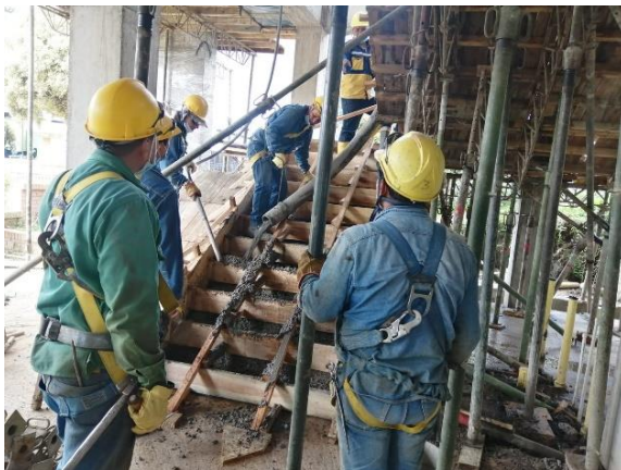
Figura 23. Aplicación concreto premezclado en escalera de piso 1 a piso 2.
