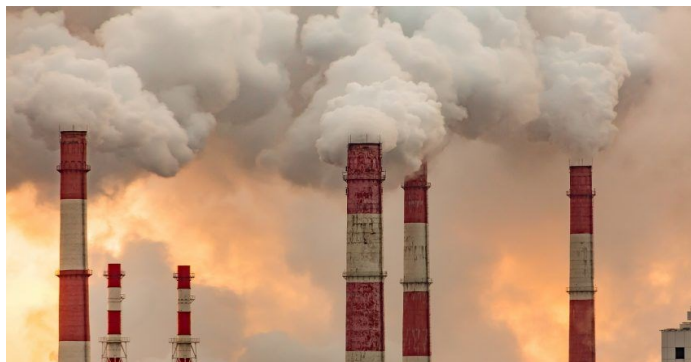
Figura 10. Emisión de productos contaminantes por chimeneas de las termoeléctricas. Fuente, Foro
