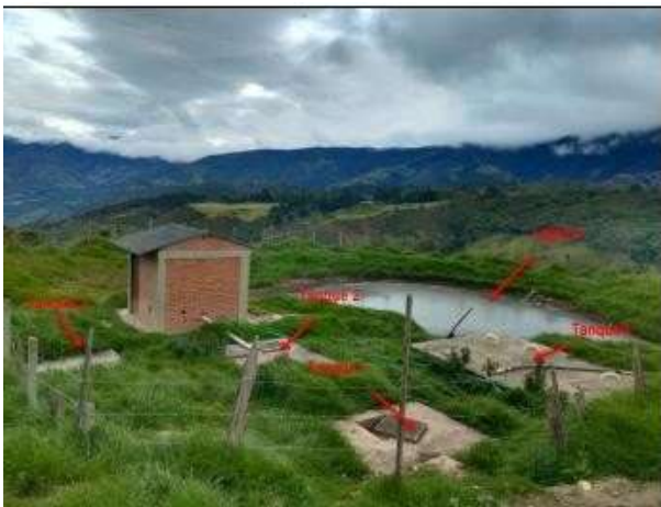
Ilustración 23. Sistema de recepción de lixiviados
