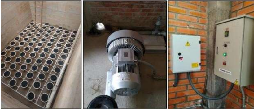
Ilustración 32. Sistema de aeración
