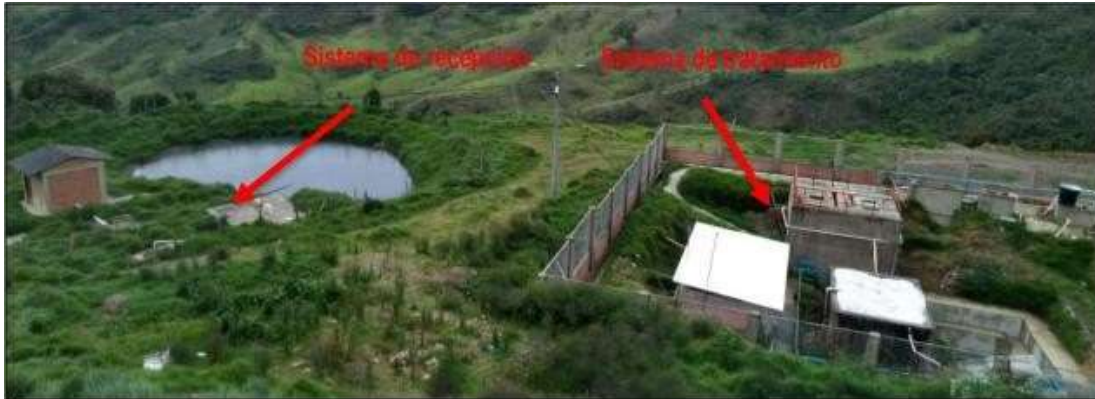
Ilustración 22. Planta de tratamiento de lixiviados
