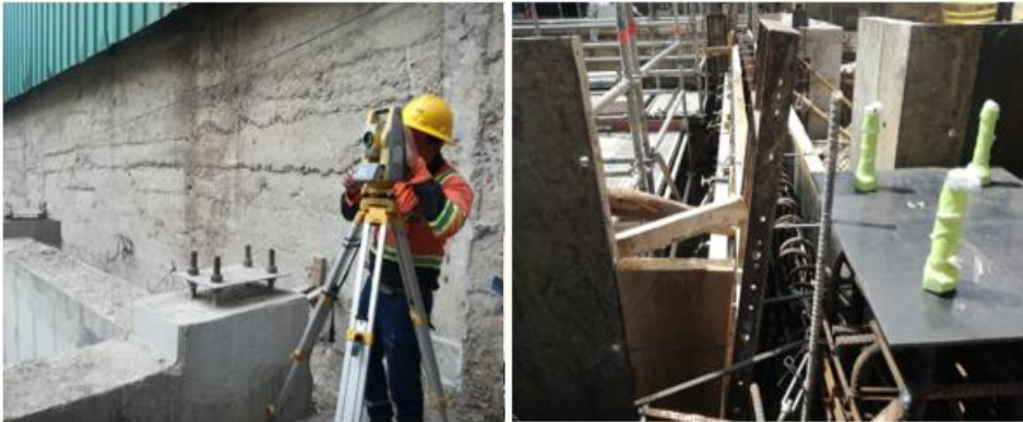
Ilustración 40 Verificación de pernos y platinas
