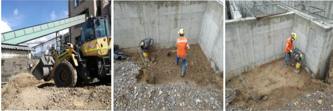
Ilustración 42 Relleno y compactación
