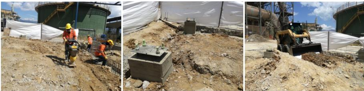
Ilustración 43 Reconformación, nivelación, extendido y compactacion de relleno
