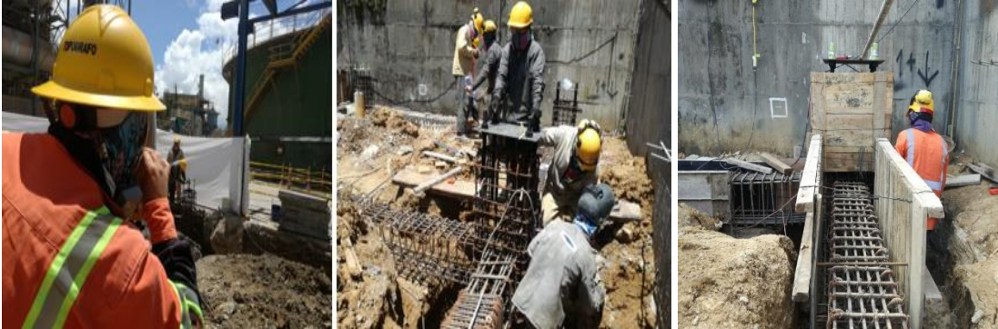
Ilustración 46 Instalación de platinas y pernos
