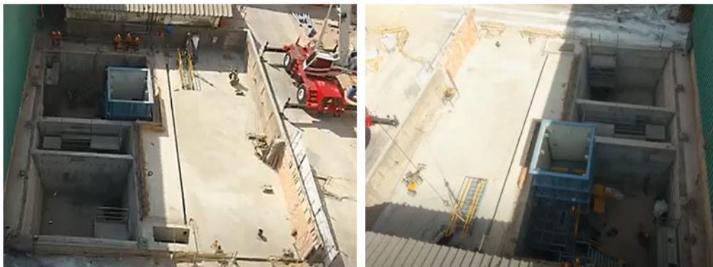
Ilustración 49 Terminación de obra
