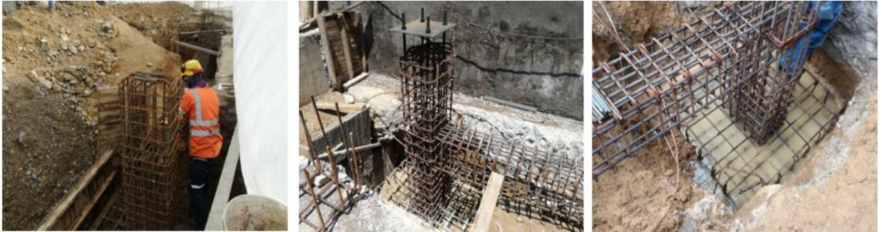
Ilustración 44 Instalación de acero
