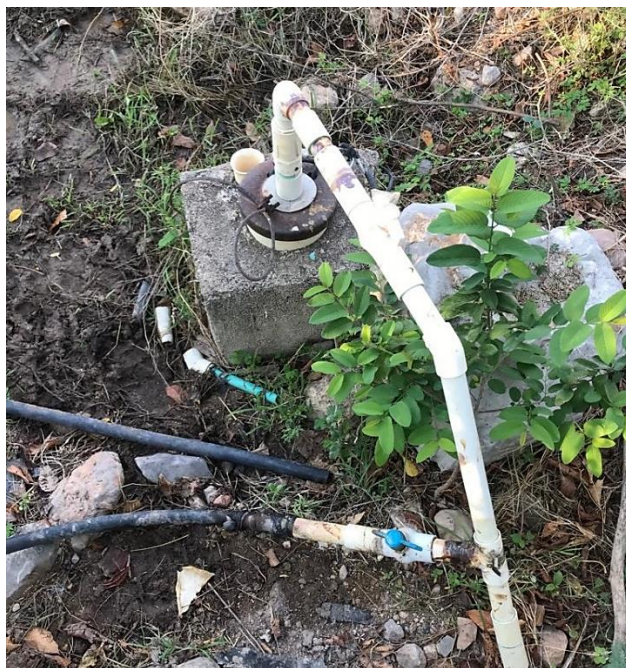
Figura 17: Pozo subterráneo construido para el aprovechamiento de aguas.
