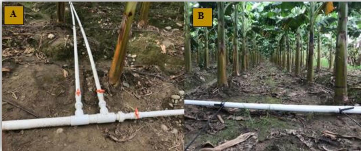
**Nota. A.** Distribución de tubería PVC 3” siendo esta la principal con laterales de 2” para formar secciones de riego con el fin de distribuir agua y nutrientes uniformemente. **B.** Laterales de cinta de goteo con espacio de 30 centímetros entre cada gotero, descarga de 1.05 litros / hora y con registro cada ramal para controlar la presión en las secciones. **Fuente:** Propia
