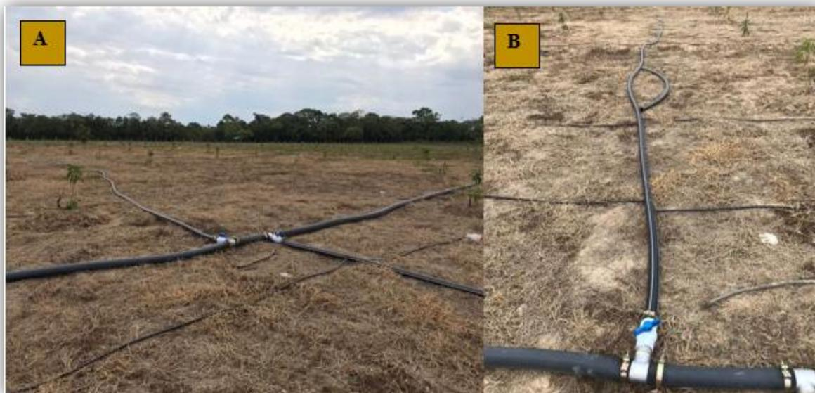
**Nota. A.** Distribución de manguera 3” siendo esta la principal con laterales de 2” para formar secciones de riego con el fin de distribuir agua y nutrientes uniformemente. **B.** Laterales de manguera 2” con registro cada ramal para controlar el agua en secciones. De allí desprenden mangueras de 16 mm y 5 mm para riego por micro aspersión o de ser el caso de goteo se desprenden el número de goteros dependiendo el tipo de suelo. **Fuente:** Propia
