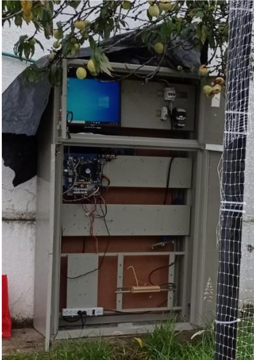
*Imagen 51 Instalación del tablero de control y distribución*
