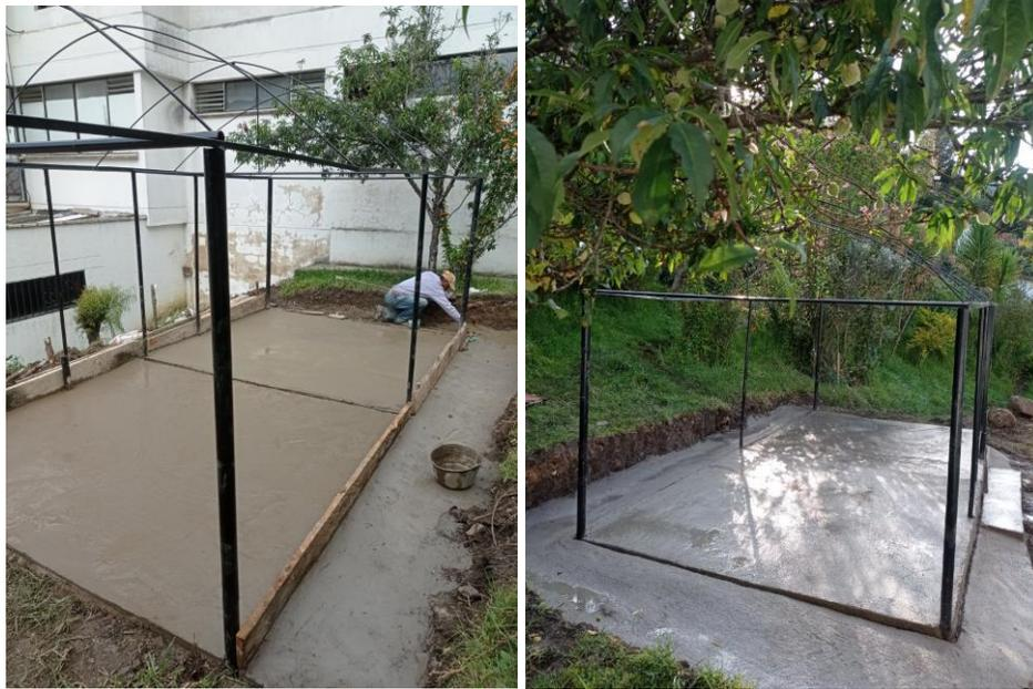
*Imagen 39 Terminación de los pisos y andenes y/o desagües*
