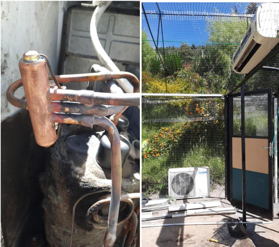
*Imagen 47 Acondicionamiento de la válvula inversora*
