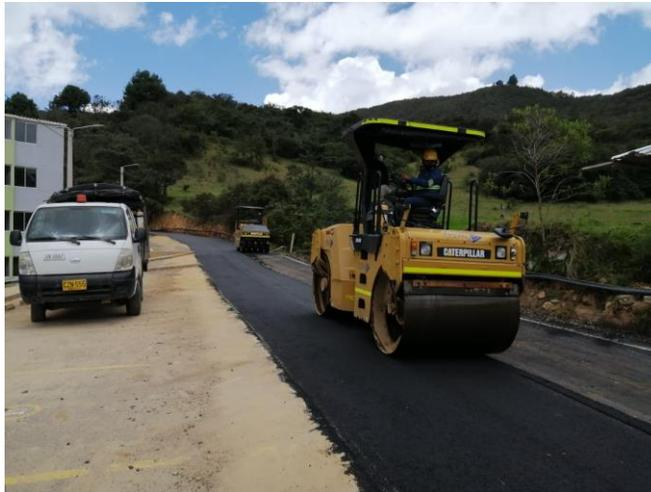
**Ilustración 41 Compactación de la mezcla asfáltica**
