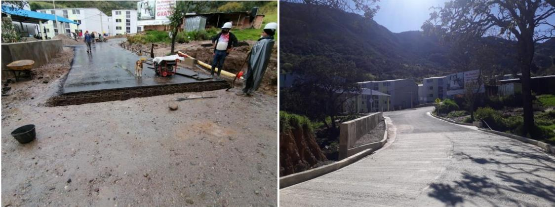
**Ilustración 20 Instalación de Pavimento flexible y Pavimento rígido**
