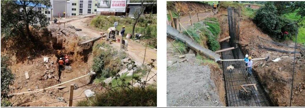
**Ilustración 15 Solado e instalación de acero**
