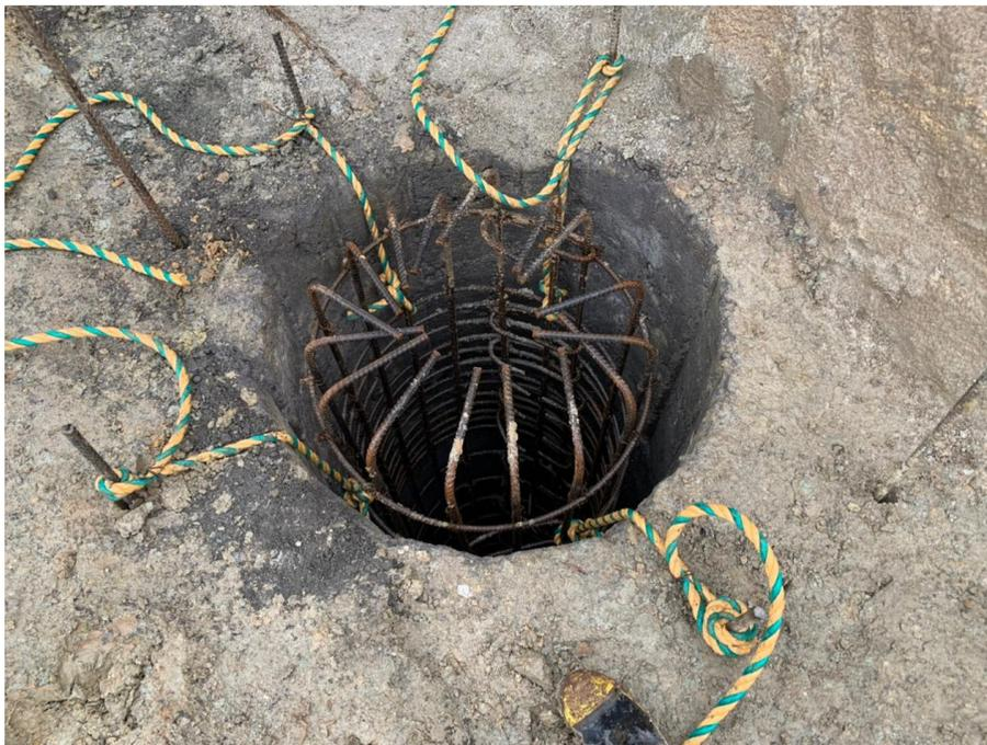
Para el vaciado de las pilas de cimentación, una vez estaban completamente armadas las pilas a vaciar, fue necesario el pedido del concreto, el cual se realizó a la empresa Argos y por una cantidad de 17 m<sup>3</sup> de concreto con 3000psi de resistencia.
