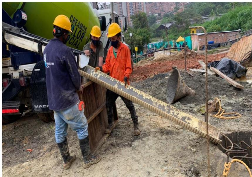
*Figura 34: Vaciado del concreto de columnas*
