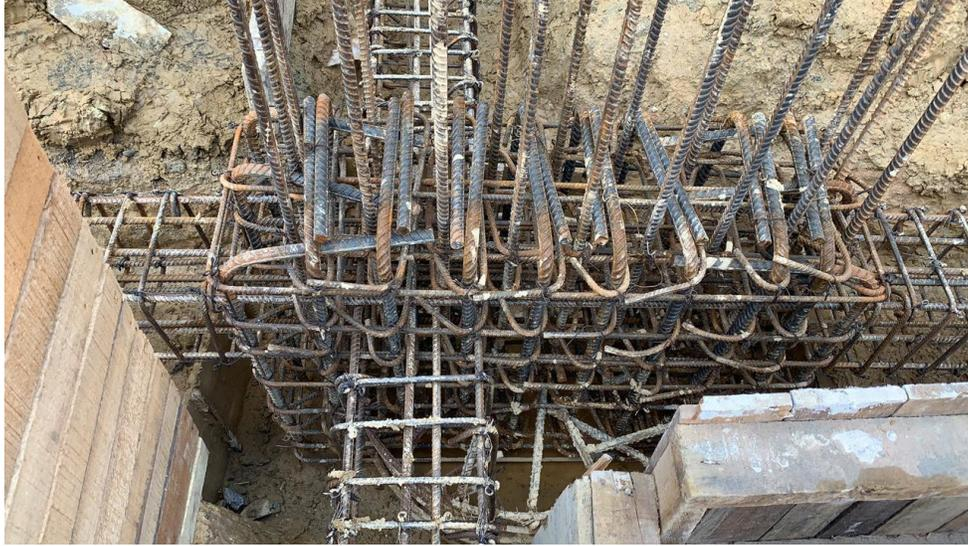
*Figura 73: Armada de equipo losa aérea o tapa de tanque*
