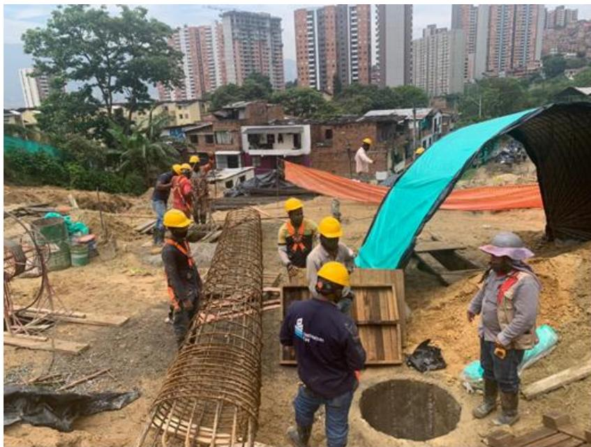
*Figura 66: Armado de Cabezote de Pilas y Vigas*
