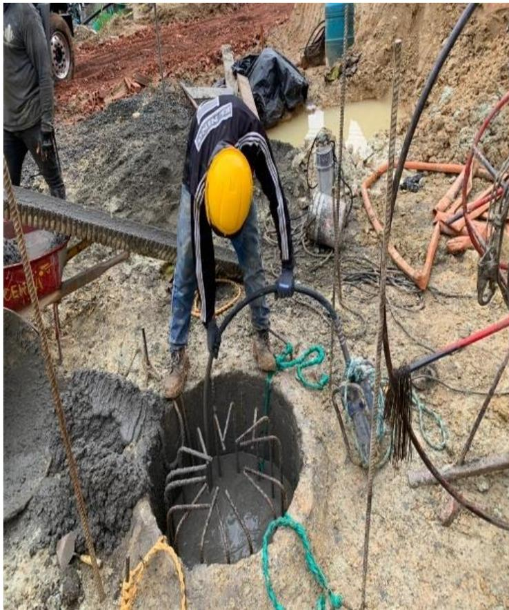
*Figura 36: Curado del concreto de las columnas*
