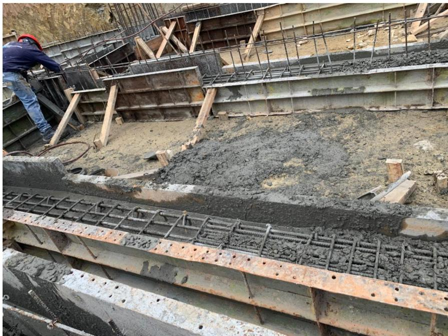
*Figura 68: Armado y vaciado de losa de contrapiso*
