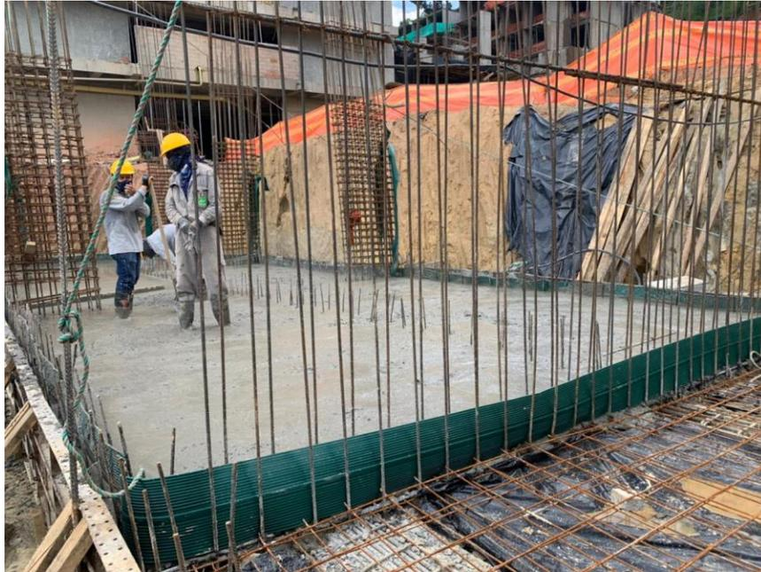
Entre los días del 17 al 21 de mayo luego de realizar el vaciado de la losa contrapiso se inició a armar las columnas que hacen parte del tanque ósea etapa 4a, así mismo se colocó la cinta PVC para evitar filtraciones por las juntas; se realizó el formaleteo de las mismas y vaciado. De la etapa 4b, se inició con la excavación de las de las vigas.
