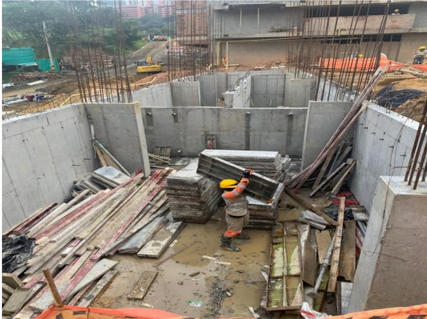
Entre los días del 03 al 11 de junio luego de realizar el vaciado de los muros completos del tanque, se inició con la armadura de la losa aérea o tapa del tanque, estos mismos días se inició con la armadura de las vigas de fundación y dados de la etapa 4b, así mismo se realizó el vaciado. Estos mismos días se armó, formaleteo y vació 6 columnas de esta misma Etapa.
