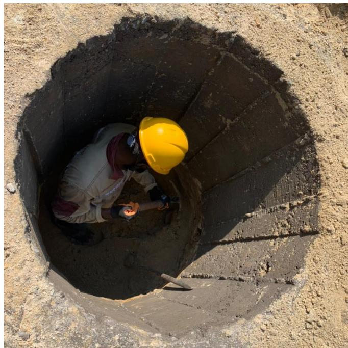
*Figura 63: Excavación y anillado de las pilas*
