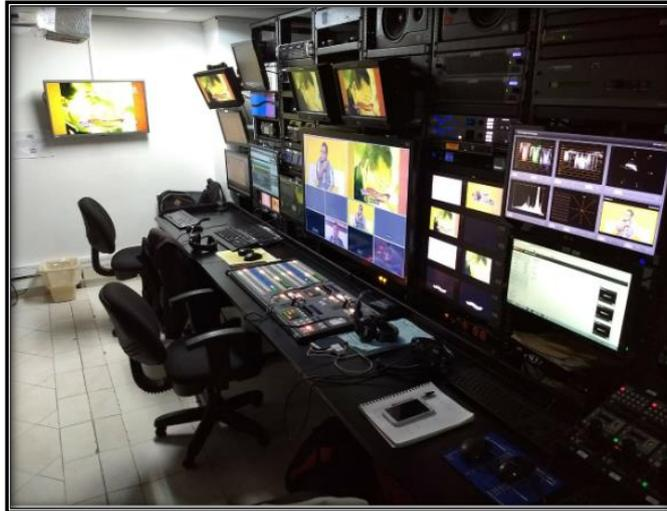
Como descripción de la figura 35 posterior, se observa que la captura de video se inicia desde una cámara, donde por medio del cable pasa a la unidad de control o “CCU”. La señal proveniente de ésta etapa es conectada a los distribuidores de video para luego ser direccionada hacia el switch de video o mezclador, en el cual el productor o director de cámaras pueda elegir cualquiera de las fuentes (CAM1, CAM2 o CAM3), para visualizar por la interfase PGM (salida de programa).
