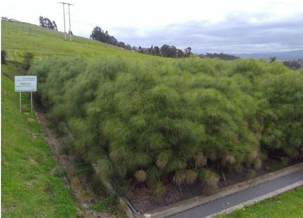
*Nota: Humedal a escala real, ubicado en la PTAR Sotaquira - Boyacá, utiliza como postratamiento de un reactor UASB, Fuente (Ibáñez & Bautista, 2018).*
