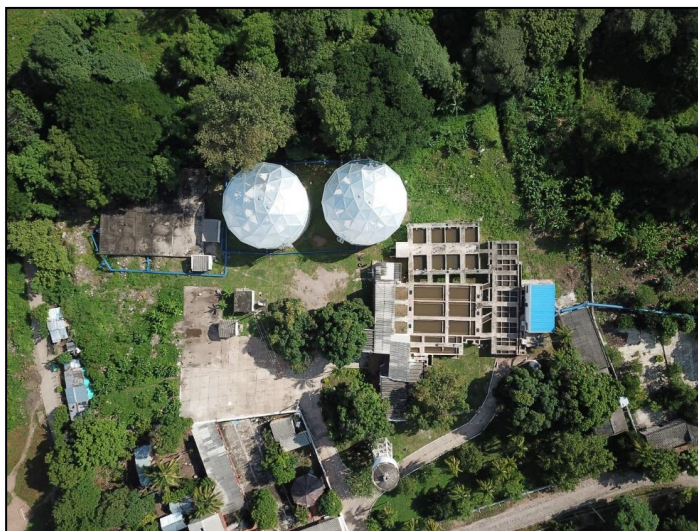
Figura 3. Planta de tratamiento de agua potable
