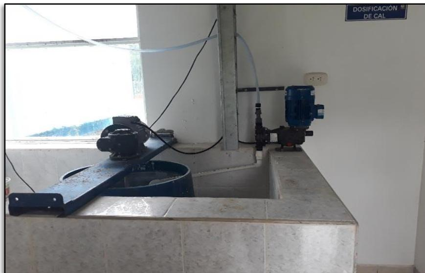
Ilustración 7. Sistema de Dosificación de Oxido de Calcio
