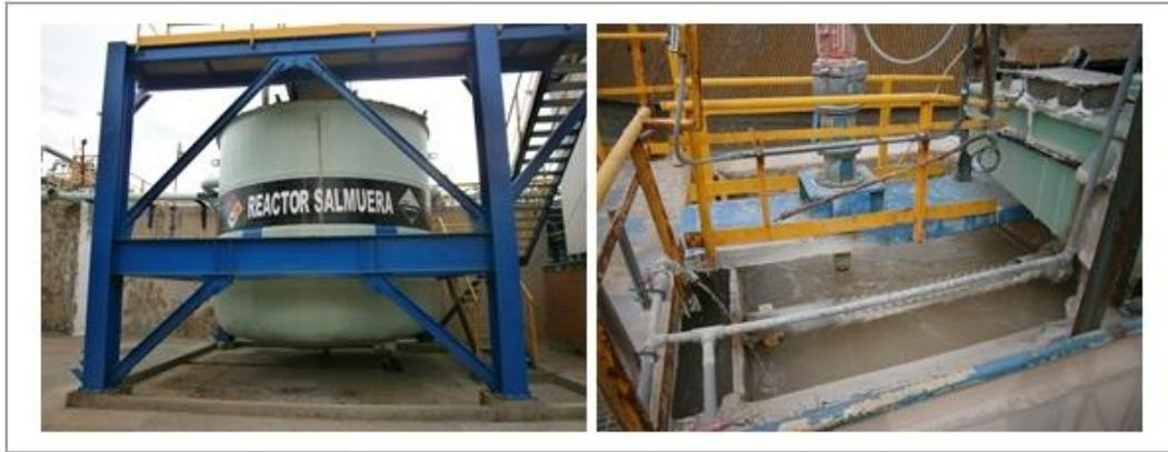
*Imagen No 4.2. Puntos de toma para control de proceso por operarios de planta*
