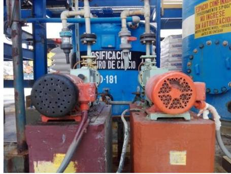
Imagen No 4.5. Bombas de dosificación  $\text{CaCl}_2$ . P-181 A/B
