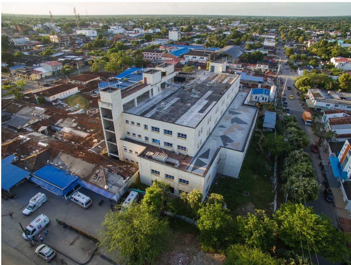
Ilustración 9. Estado actual torre de urgencias. Fuente: Gobernación de Arauca
