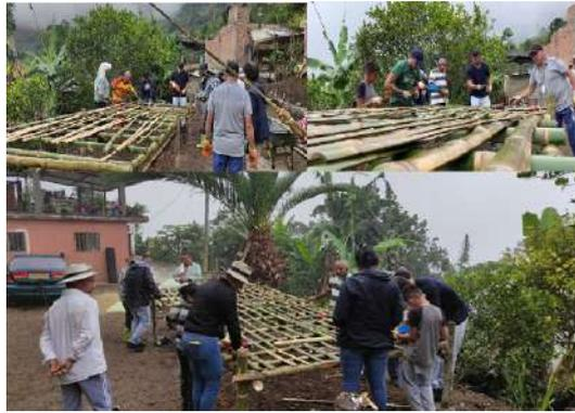
**Figura 6.33:** bases laterales para cama de secado
