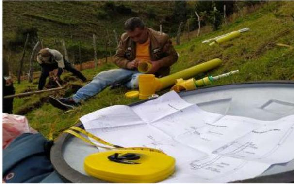
**Figura 7.8:** Construcción de filtro en PVC.
