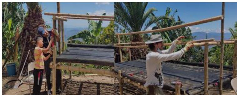
**Figura 6.35:** construcción de bases para puertas y ventanas
