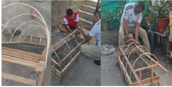
**Figura 6.16:** soporte y separación de arcos
