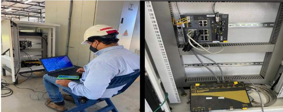
**Figura 5.11:** Pruebas desde switch a laptop para verificar la vinculación de los relés respecto a la arquitectura de anillo
