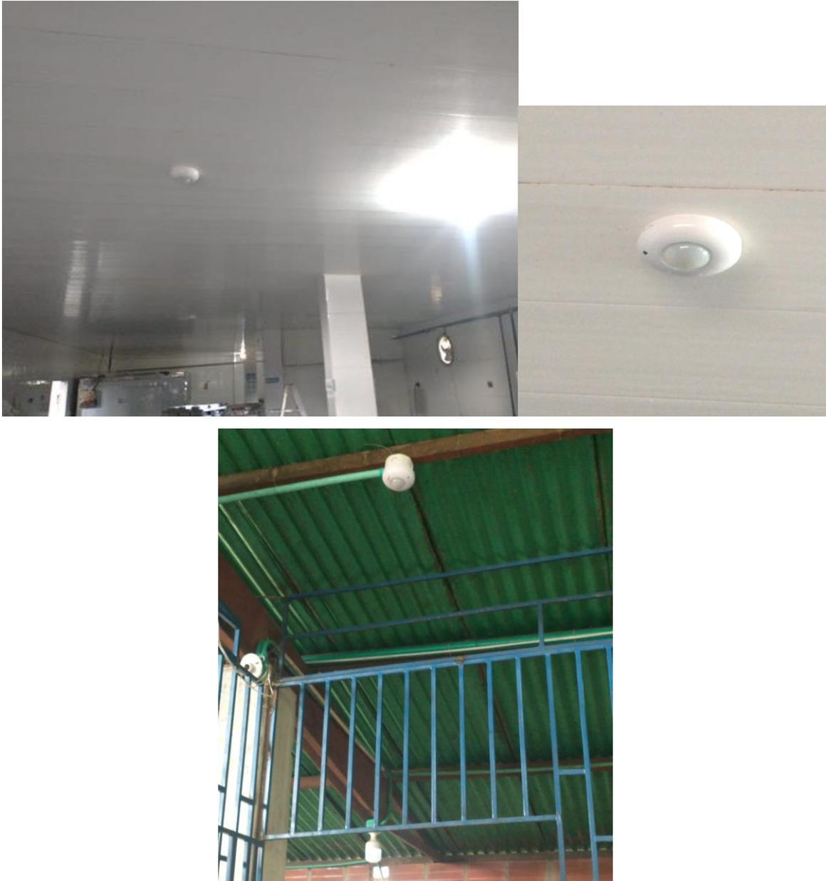
Figura 45. Instalación de sensores de movimiento en la planta de la empresa
