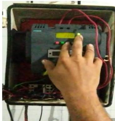
Figura 49. programación de variador de frecuencia
