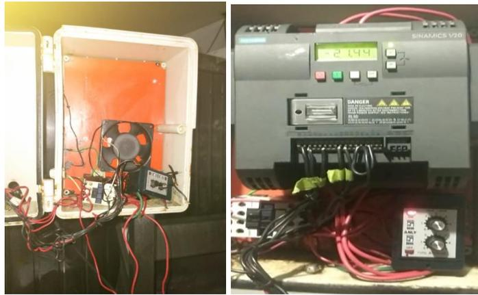
Figura 48. Instalación y revisión conexiones tablero, sunamis v20
