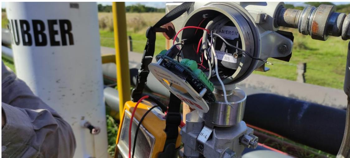
**Imagen 15.** Revisión de transmisor indicador de flujo (Camerón 2000). Autor.
