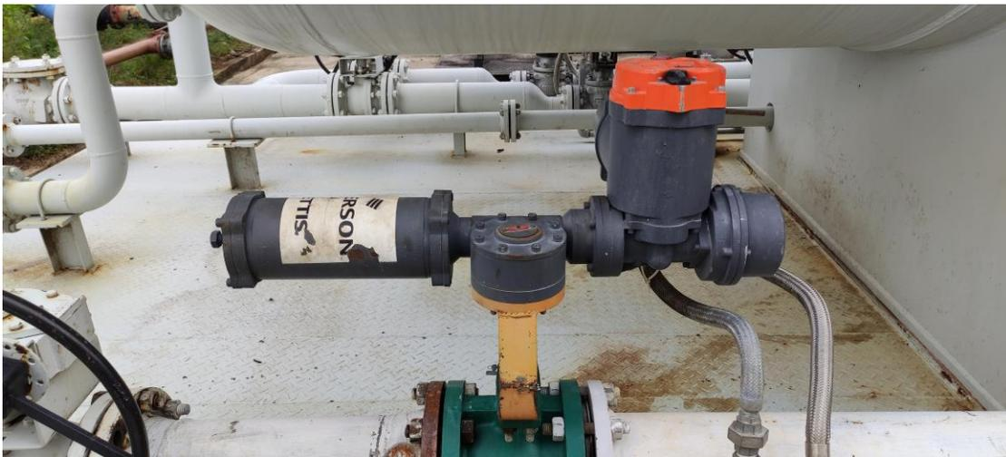
**Imagen 16.** Inspección de válvula controladora de nivel. Autor.
