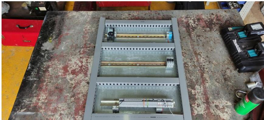
**Imagen 18.** Instalación de ductos ranurados 40x40 mm. Autor.
