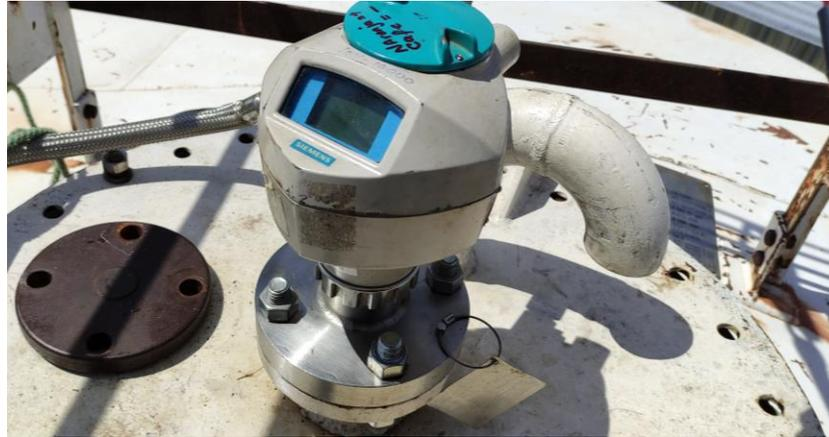
**Imagen 29.** Sensor Tipo Radar Sitrans LR250 Instalado en Campo.
