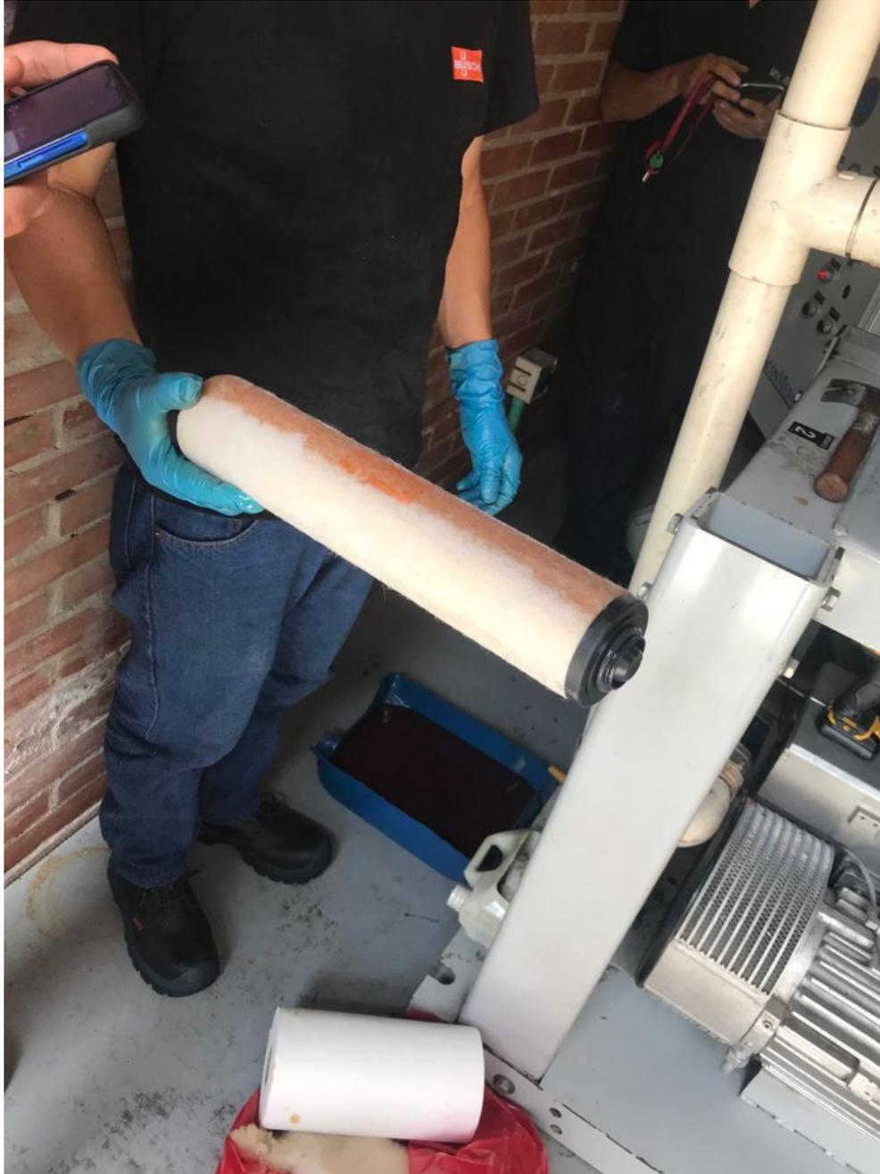
**figura 42** Cambio de filtros de bomba de vacío en mantenimiento
