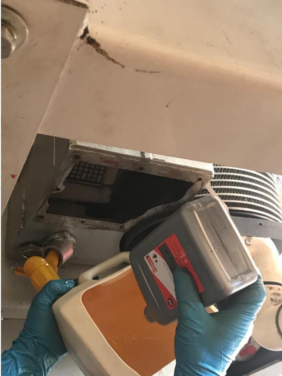
**figura 44** Cambio de aceite de bombas de vacío
