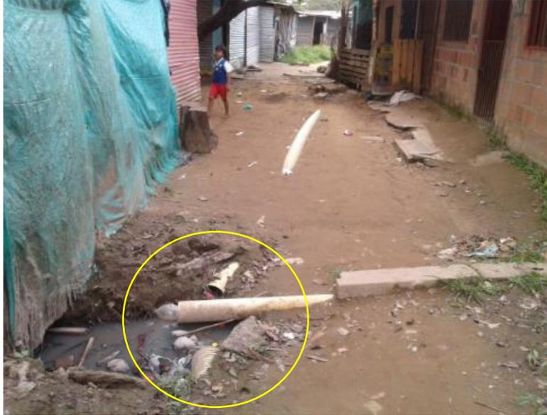
*Ilustración 32: Sistema vertedero de aguas negras del asentamiento.
