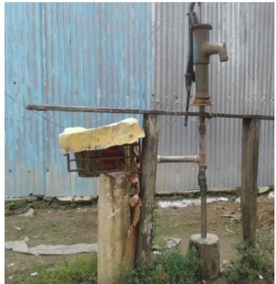
*Ilustración 31: Abastecimiento de agua por puntillos. Puntillo comunal (izquierda) Puntillo de una familia (Derecha)*
