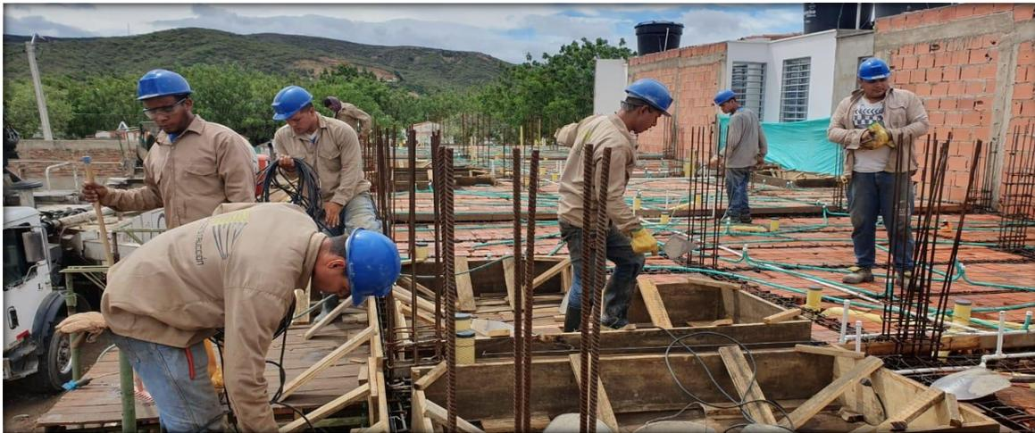
**Figura 11. Trabajo de tuberías**
