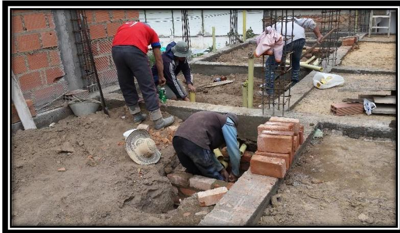
**Adecuación de tubería sanitaria en caja de inspección para la casa #12.**
