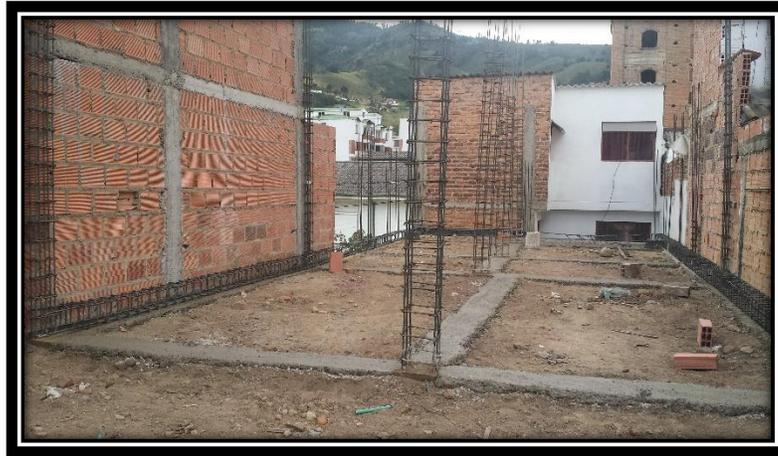
**Solado para armado de hierro de viga de cimentación para la casa #12.**
