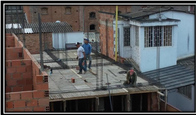
**Armado de hierro de vigas para placa de 1er piso de la casa #12.**
