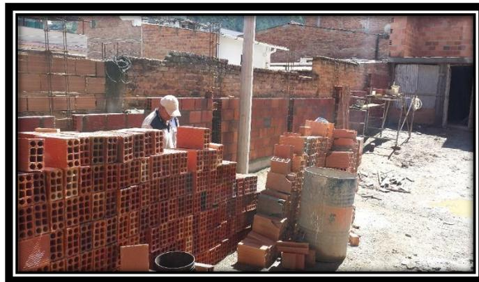
Figura 2. **Apilamiento de bloque dentro de obra.**
