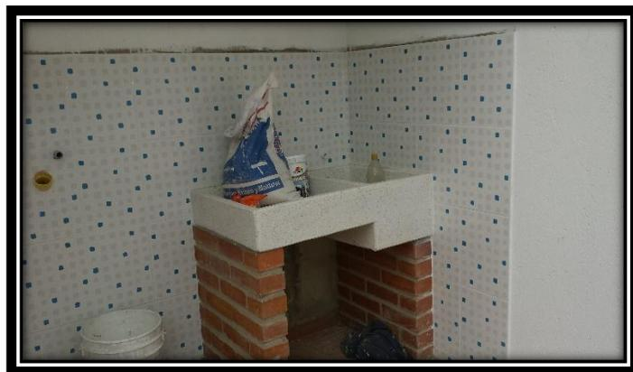
**Enchape de muros y colocación de lavadero prefabricado en la casa #10.**
