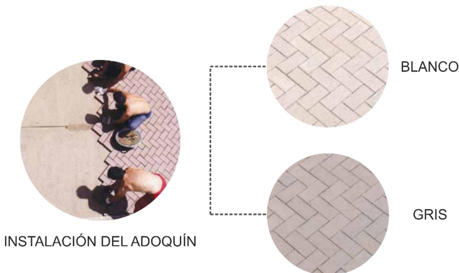
Los adoquines están diseñados para poder ser colocados en obra manualmente, de manera sencilla y con pocas herramientas, aunque también se han desarrollado equipos para su colocación mecanizada.
