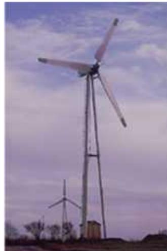
Figura 10. Torre de Mástil Tensado
