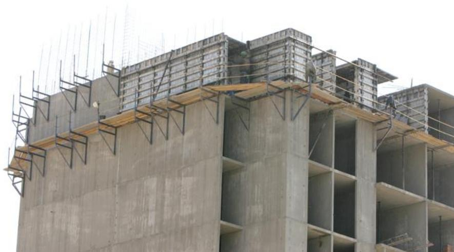
Fotografía: Sistema manoporable para la construcción de viviendas multifamiliares de concreto.
