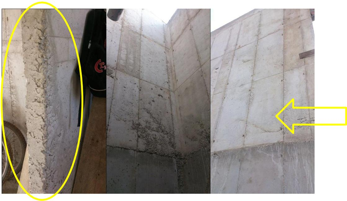
*Fotografía 3. Trabajo mal ejecutado por no realizar un vibrado adecuado a la hora de fundir, ocasionando hormiguo en los muros estructurales.*
