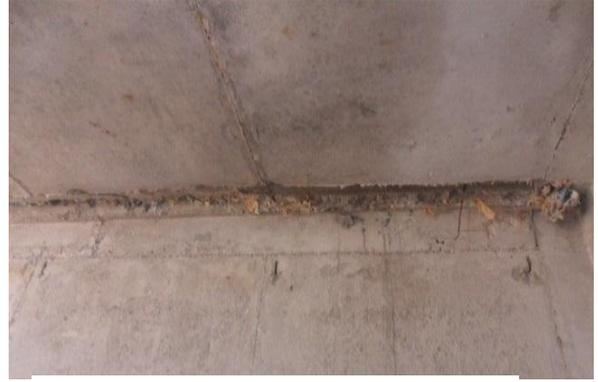
*Fotografía 2. Trabajo mal ejecutado por Falta de equipos complementarios de formaletería.*
