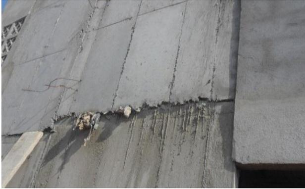
*Fotografía 1. Trabajo mal ejecutado por el alineamiento de los muros estructurales.*
