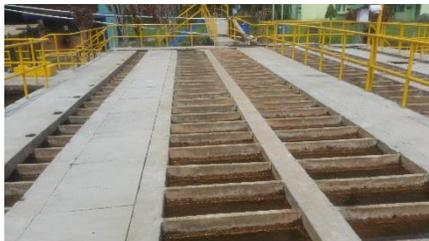
**Imagen 9.** Tanque de floculación
