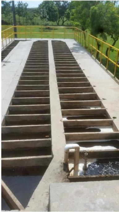
**Imagen 7.** Tanques de floculación
