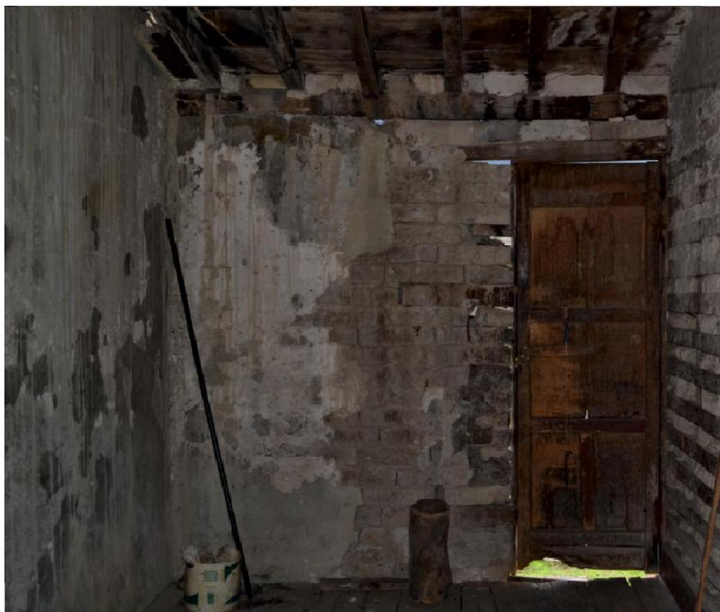
Imagen No. 77. Muros de carga en adobe y tablones. Fuente: Elaboración propia, trabajo de campo, 2016.
