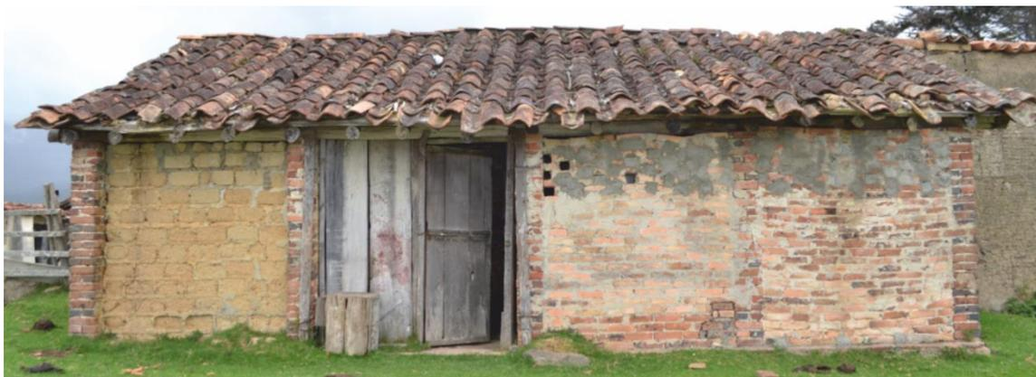
Imagen No. 75. Depósito de la caballeriza ubicado al sur-oeste construido con muro carguero (ladrillo tolete). Fuente: Elaboración propia, trabajo de campo, 2016
