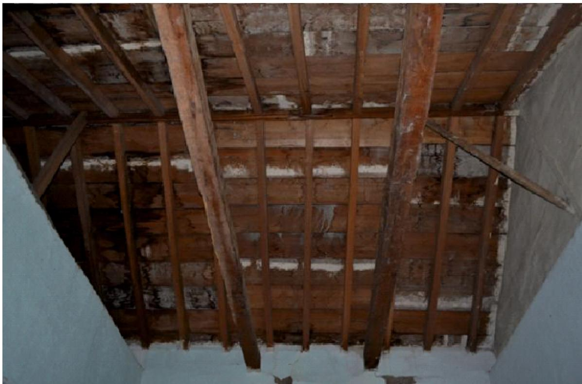
Imagen No. 70. Estructura de cubierta y entablado. Ubicada en la habitación gaitanera. Fuente:
