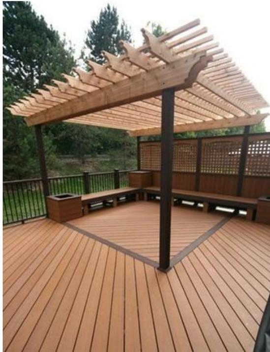
Ilustración 7: Utilización de la madera plástica en las construcciones
