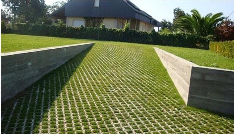
Ilustración 6: Utilización en suelos del adoquín ecológico
