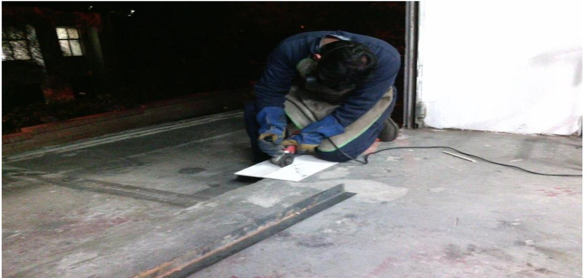
*Figura 47. Corte del aislante térmico*
