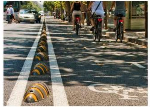
**Figura 132. Separadores de carril fabricados con residuos de cables eléctricos. (elpais.com, 2011).**
