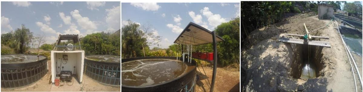
**Grafico N° 9. Blower, motobomba, sistema de energía solar, tanques en geomembrana y pozo subterráneo. Fuente personal.**
