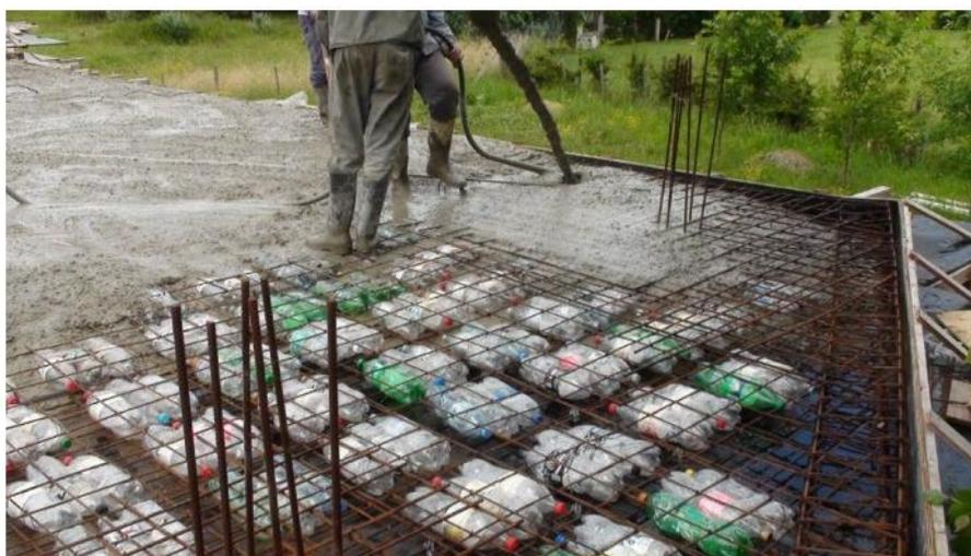
“fundición y vibrado de placa aligerada con botellas pet”
