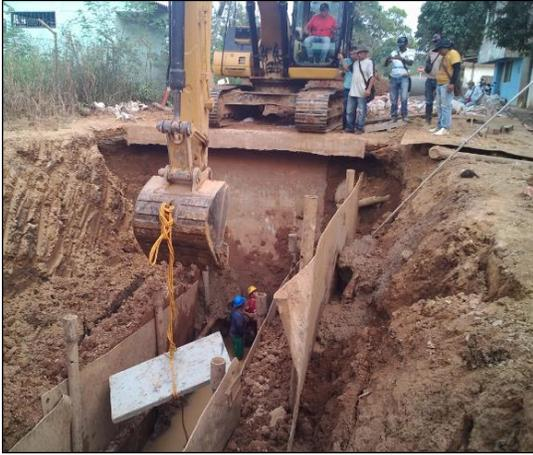
*Ilustración 14 instalación de placas para estabilizar*
