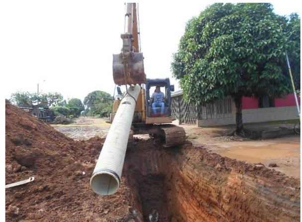
*Ilustración 19 colocación de tubería*
