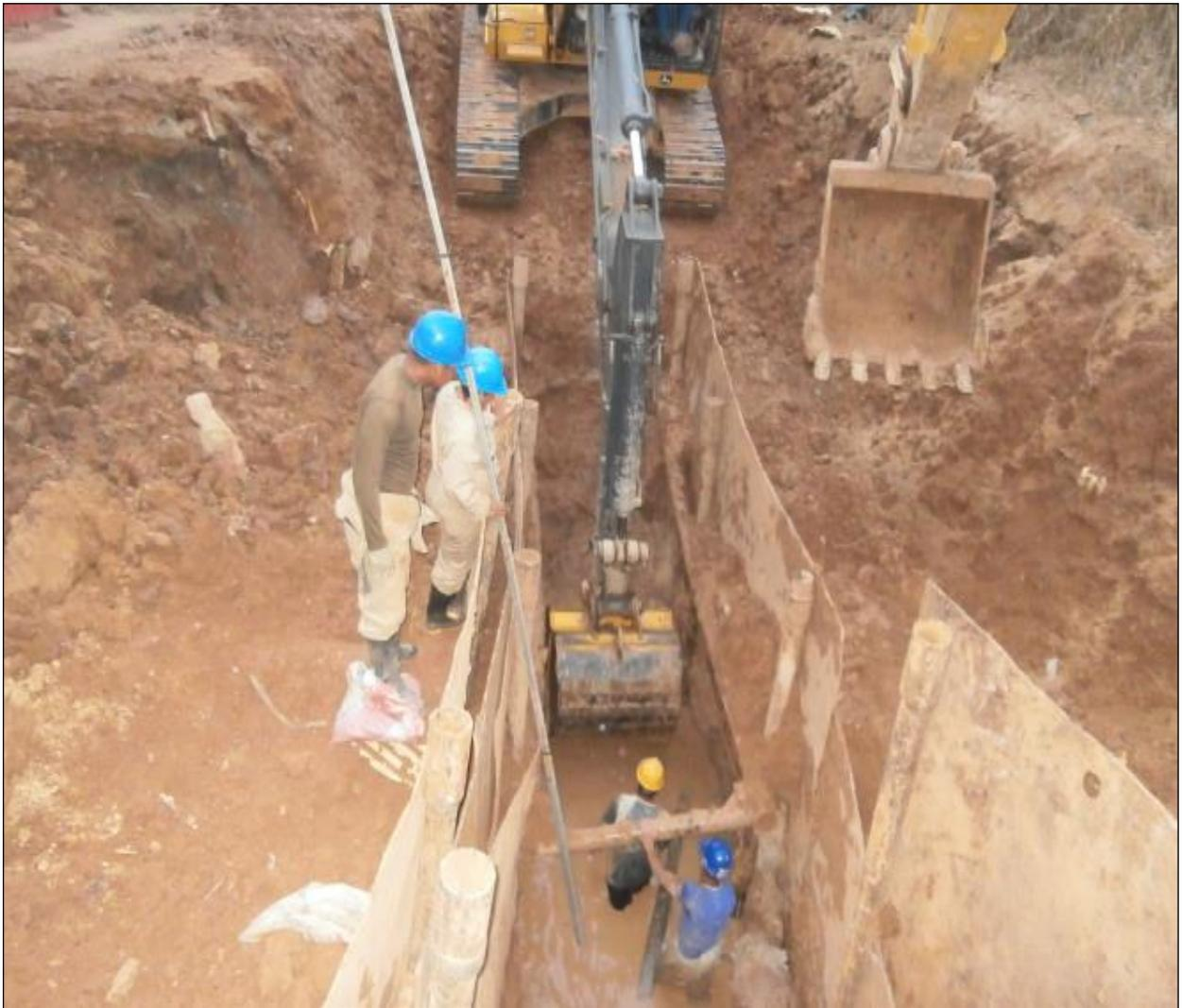
*Ilustración 20 excavación mecánica*
