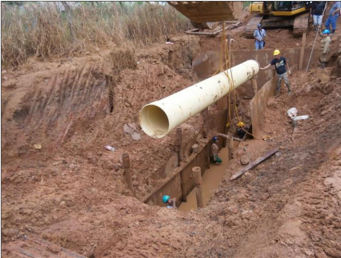
*Ilustración 23 instalación de 24"*
