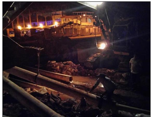
*Ilustración 12 instalación de tubería*
