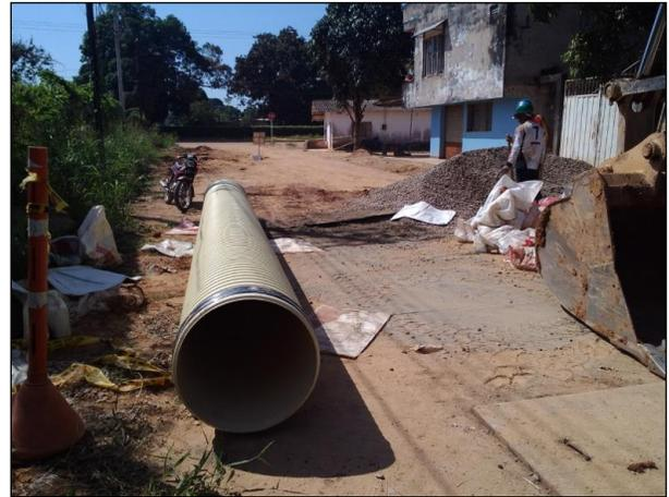
Ilustración 22 tubería de 24"
