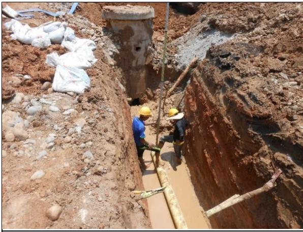
*Ilustración 18 colocación de tubería*
