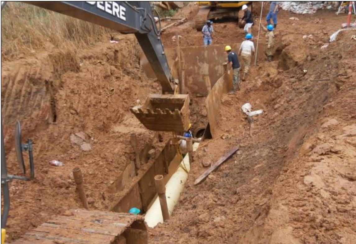
*Ilustración 7 excavación y colocación de tubería*
