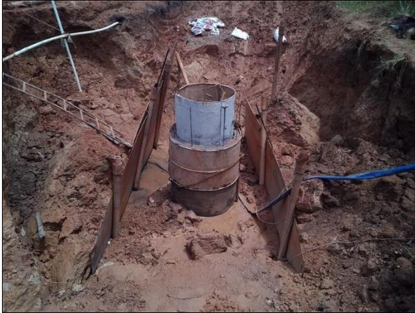
*Ilustración 9 cámara de inspección 55*
