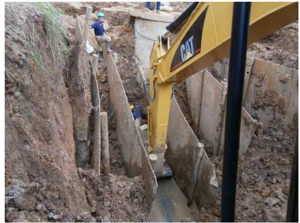
*Ilustración 10 excavación mecánica*
