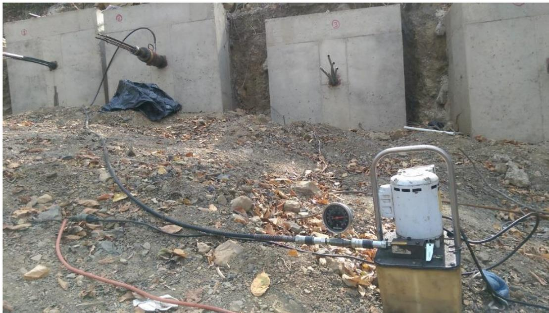
**Fotografía 29.** Proceso de tensionamiento. **Fuente:** Autor
