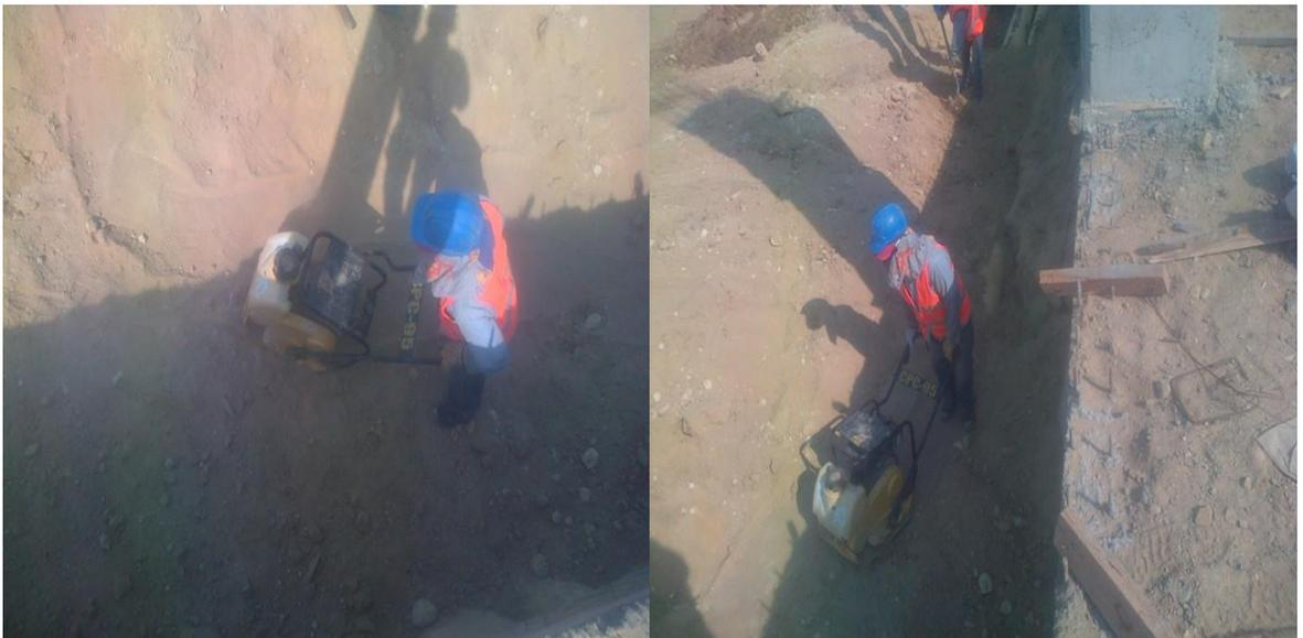
Ilustración 32. Compactación del relleno de zanjas para alcantarillado pluvial. Fuente: Autor.
