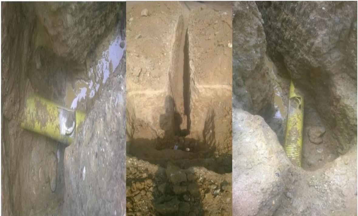
Ilustración 43. Tubería PVC rota y llena de material fangoso. Fuente: Autor.
