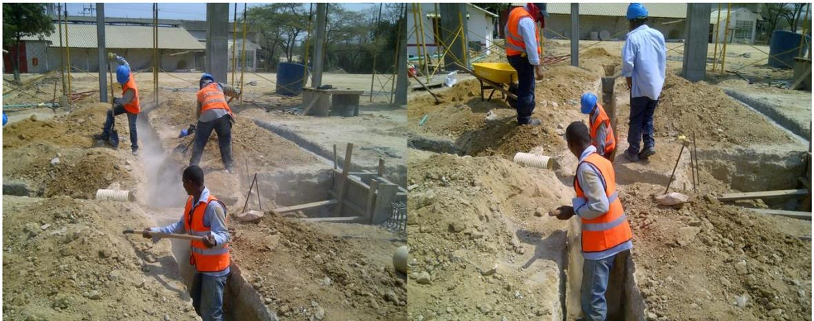
Ilustración 28. Relleno de zanjas. Fuente: Autor.
