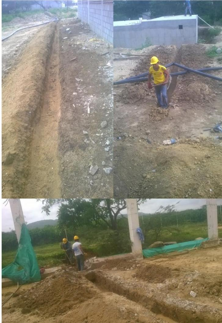
Ilustración 25. Zanjas para tubería de agua potable e industrial. Fuente: Autor.
