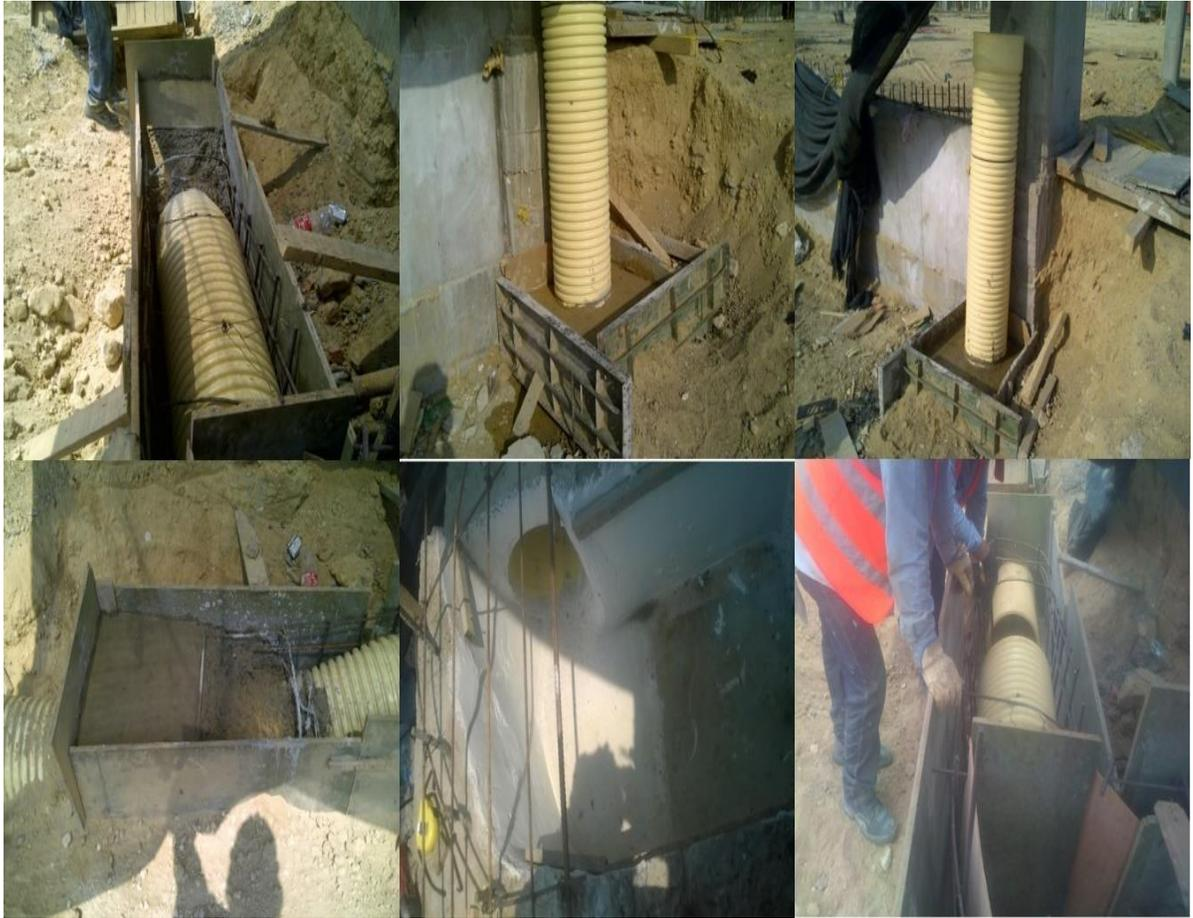
Ilustración 40. Vaciado de concreto e impermeabilización de cajas de inspección pluviales. Fuente: Autor.
