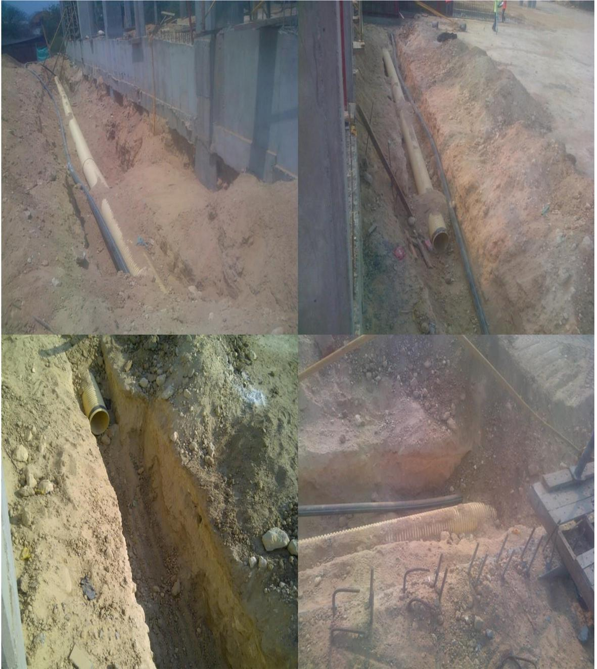
Ilustración 30. Instalación de tubería de alcantarillado pluvial PVC tipo fort de 16". Fuente: Autor.
