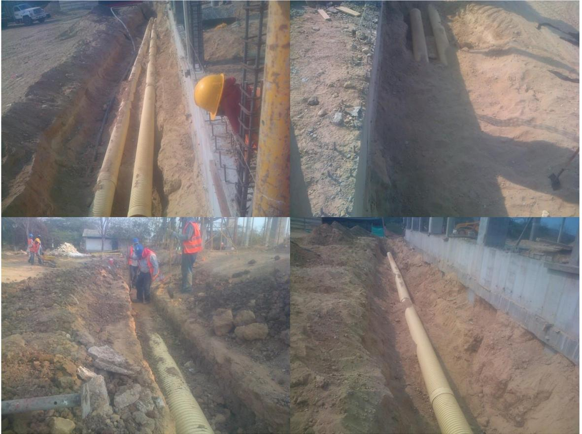
Ilustración 31. Relleno de zanjas para alcantarillado pluvial. Fuente: Autor.
