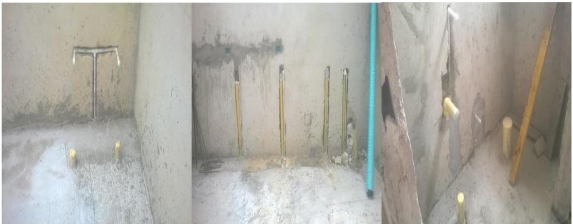
Ilustración 42. Instalación de puntos de agua potable. Fuente: Autor.
