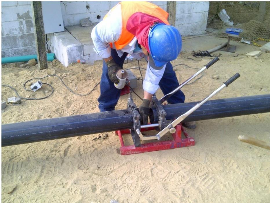
Ilustración 33. Unión de tubería PEAD por termofusión. Fuente: Autor.
