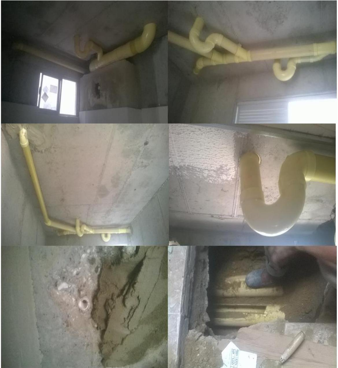
Ilustración 5. Revisión de redes hidrosanitarias después de vaciado de concreto y evaluación de daños. Fuente: Autor.
