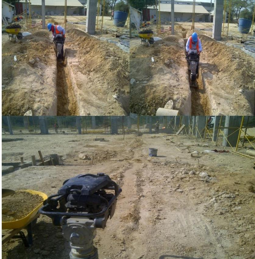
Ilustración 29. Compactación de relleno de zanjas en capas de 0.3m. Fuente: Autor.
