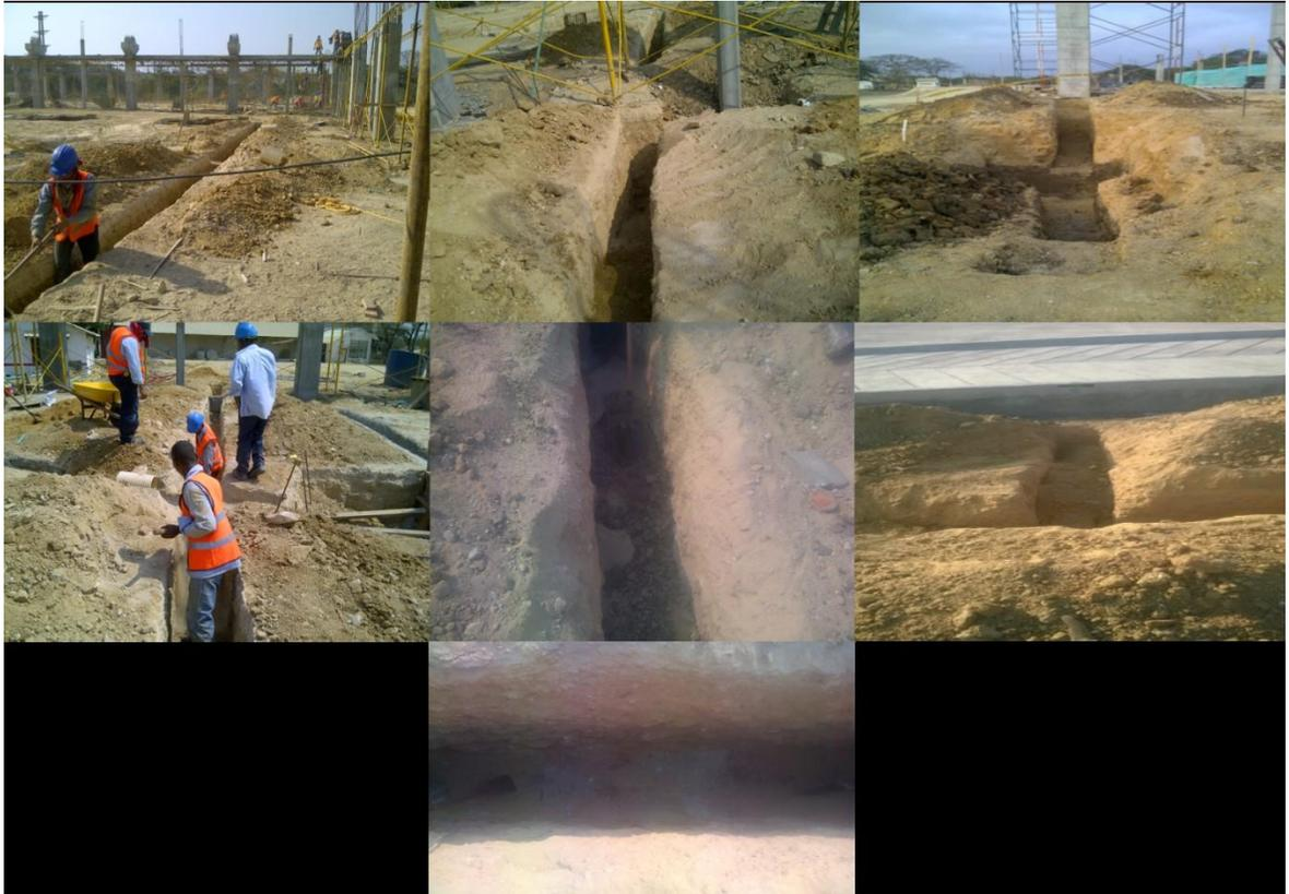
Ilustración 22. Zanjas para alcantarillado sanitario. Fuente: Autor.
