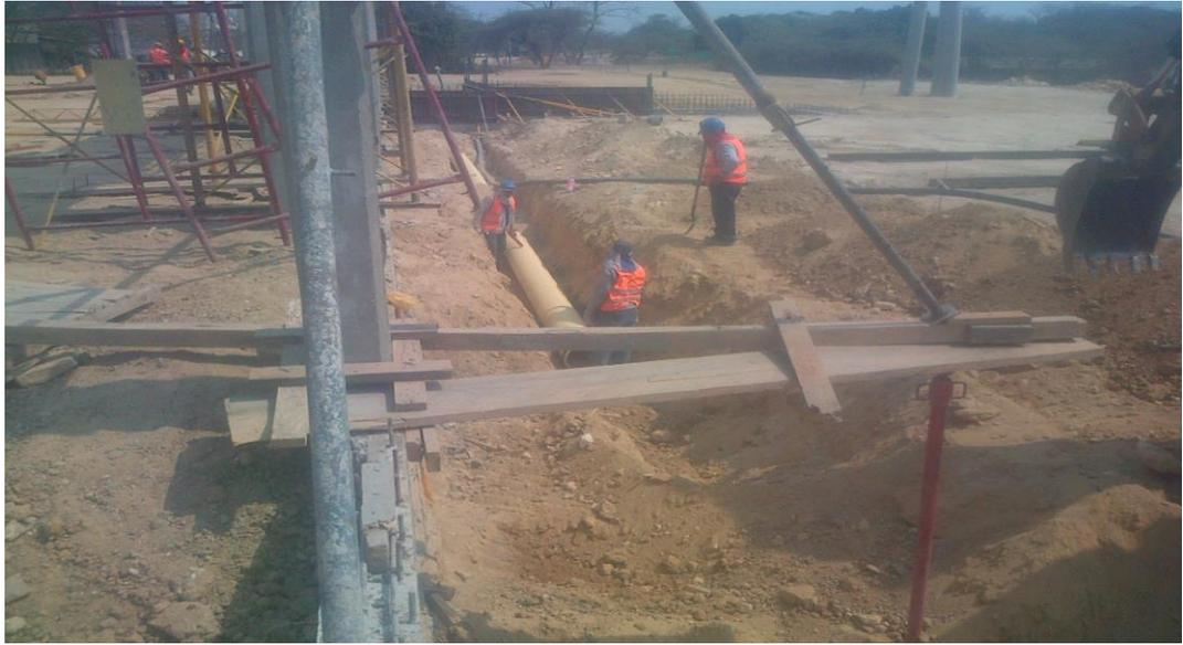
Ilustración 23. Zanja para alcantarillado pluvial. Fuente: Autor.
