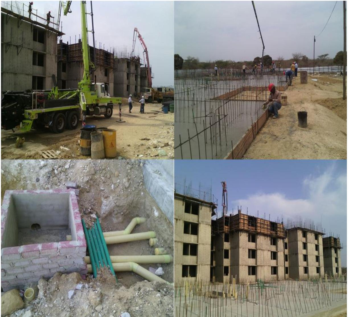
Ilustración 4. Sistema de construcción monolítica que requiere primero fijación de redes hidrosanitarias. Fuente: Autor.
