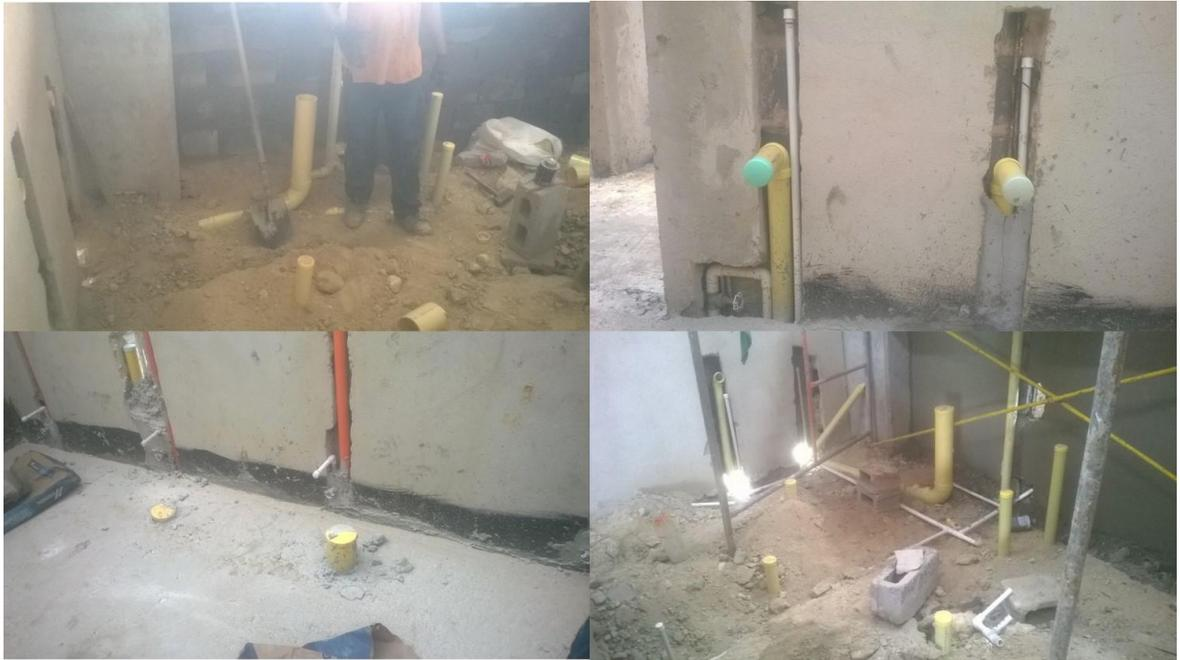
Ilustración 41. Instalación de puntos sanitarios. Fuente: Autor.
