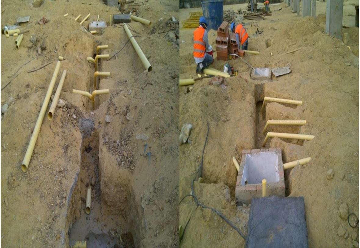
Ilustración 26. Instalación de ramales de tubería sanitaria. Fuente: Autor.
