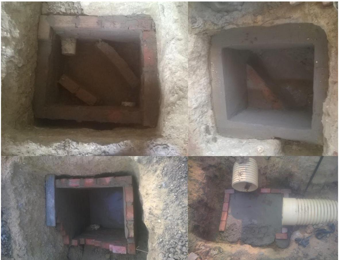
Ilustración 38. Cajas de inspección sanitaria. Fuente: Autor.
