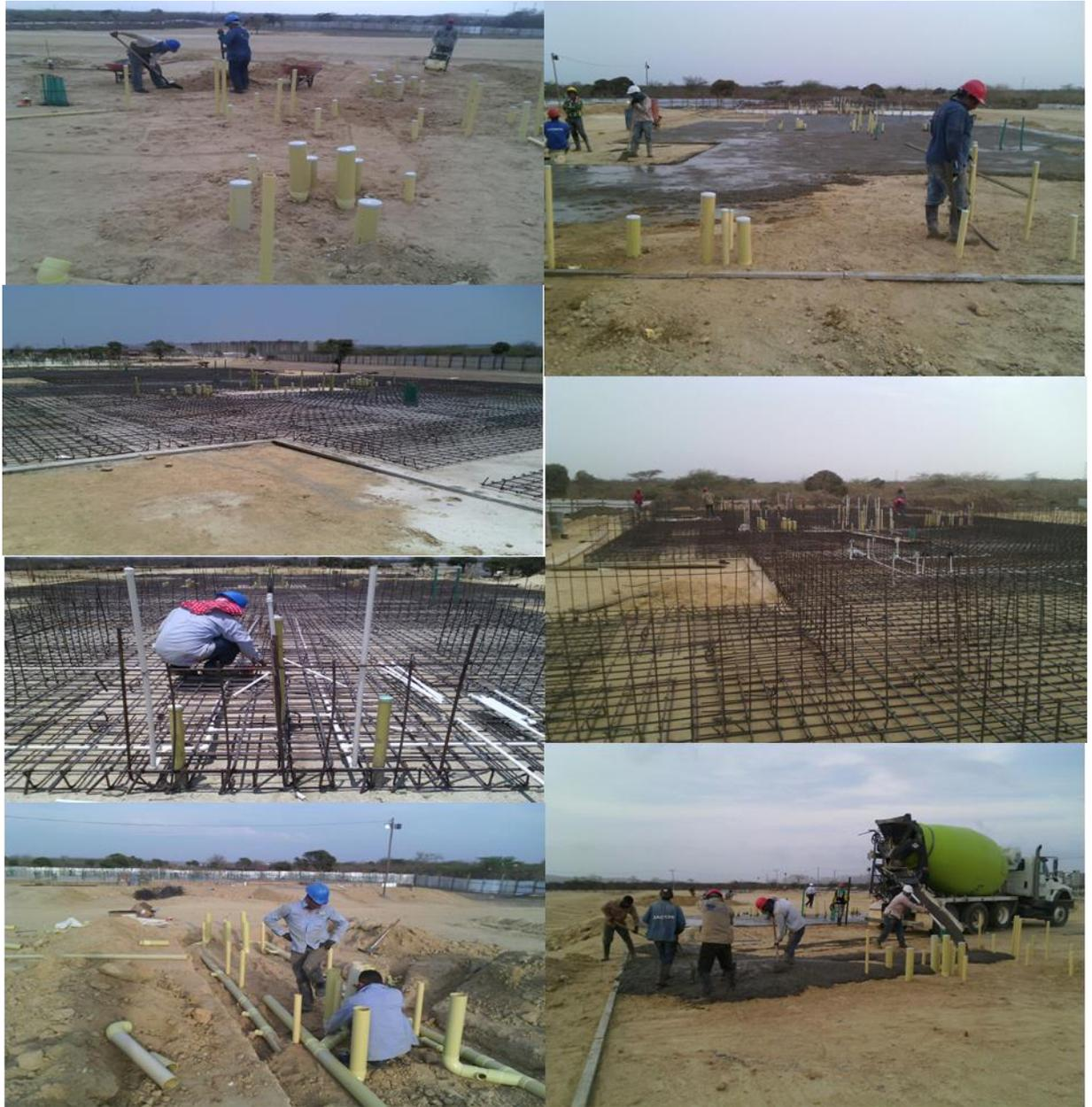
Ilustración 3. Preparación de redes de tubería sanitaria y potable previo al vaciado de plantilla. Fuente: Autor.
