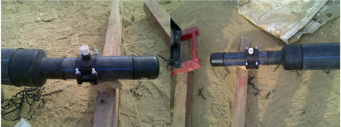
Ilustración 34. Accesorios PEAD. Collar de derivación y tapón soldado por termofusión. Fuente: Autor.
