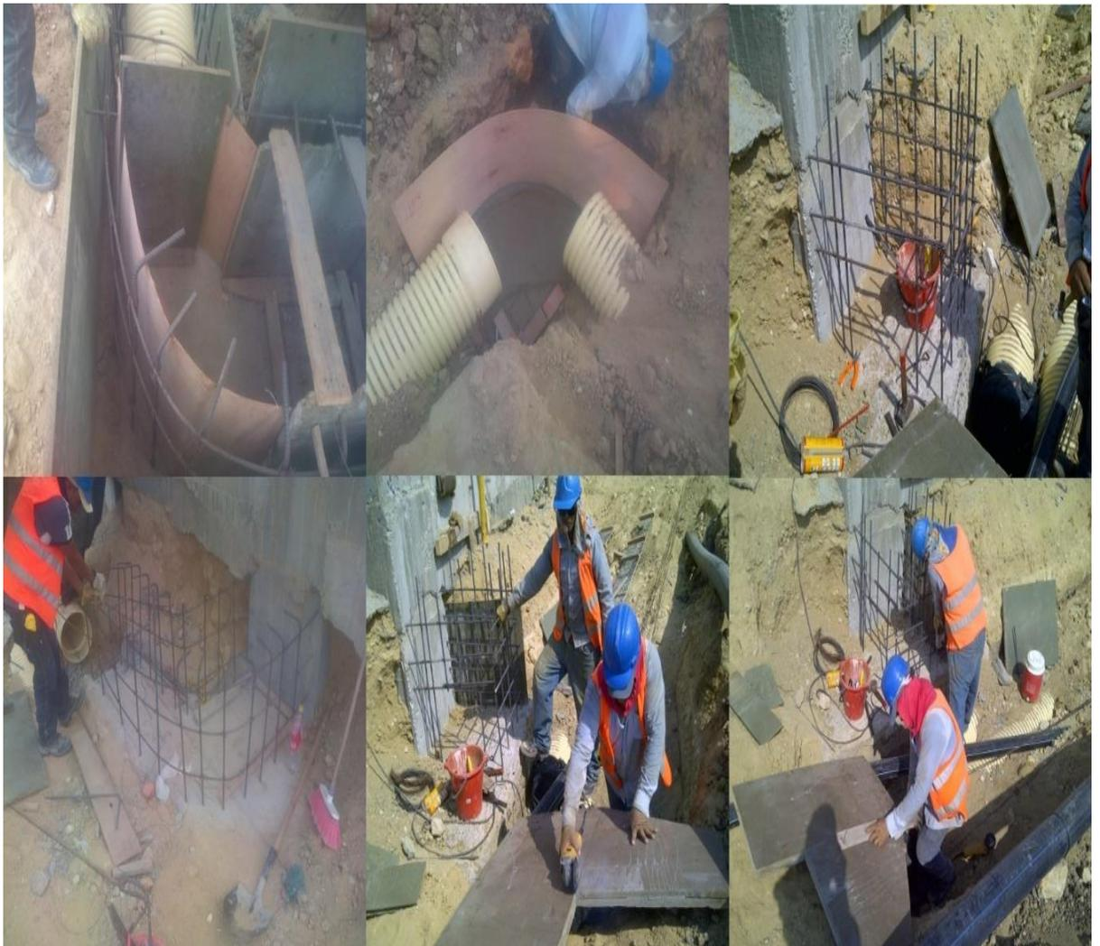
Ilustración 39. Instalación de formaleta y figurado de acero para construcción de caja de inspección pluvial.
