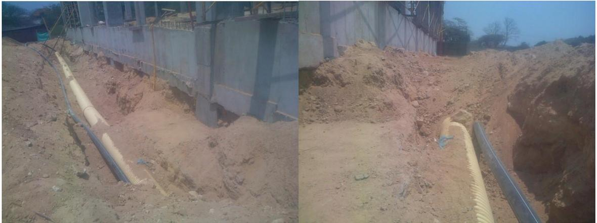
Ilustración 35. Instalación de tubería PEAD. Fuente: Autor.
