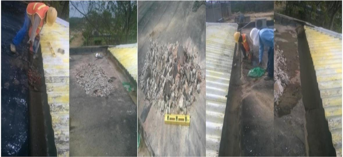
Ilustración 44. Demolición de canaleta y vaciado de plantilla en mortero.
