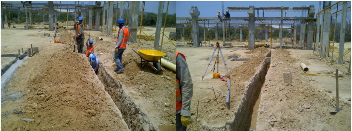
Ilustración 21. Replanteo de excavaciones con equipo de precisión topográfica. Fuente: Autor.
