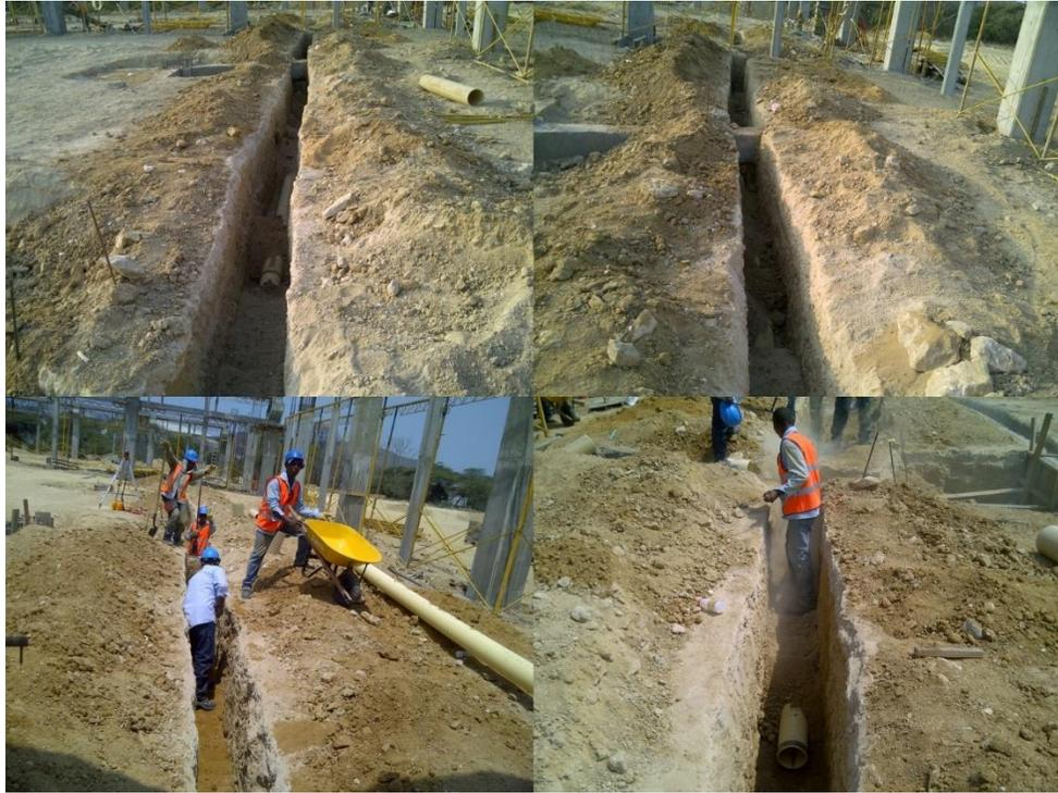
Ilustración 27. Recubrimiento de tubería sanitaria con arena. Fuente: Autor.
