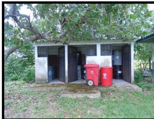
Fotografía 61: Cuarto de almacenamiento de los residuos peligrosos y no peligrosos sin señalización.
