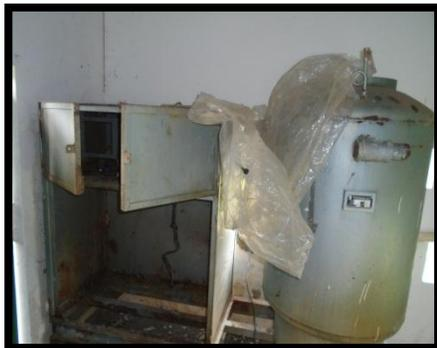
Fotografía 72: Dosificador de clorox dañado.
