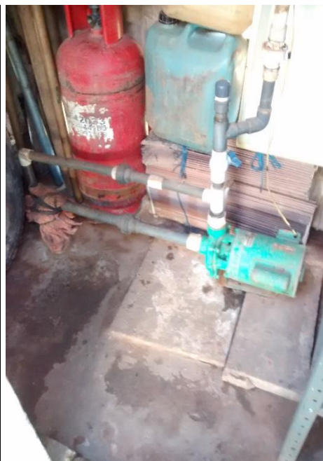
Fotografía 86. Punto en el barrio Bello Horizonte
