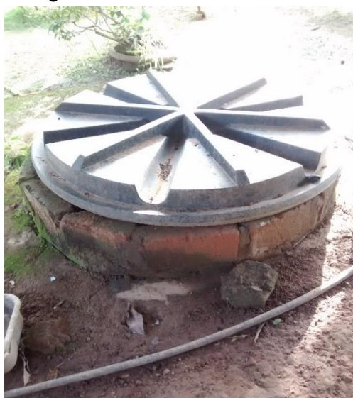
Fotografía 72. Punto en el barrio Caudal
